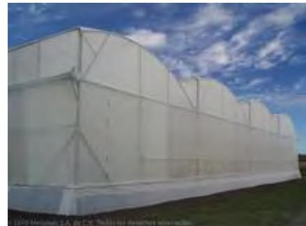
Poliétileno blanco 30% sombra Larga duración de 720 galgas de espesor. La sujeción se realiza mediante un perfil clip y dos perfiles de PVC que conjugan la facilidad de montaje con una gran resistencia a las intemperies.
