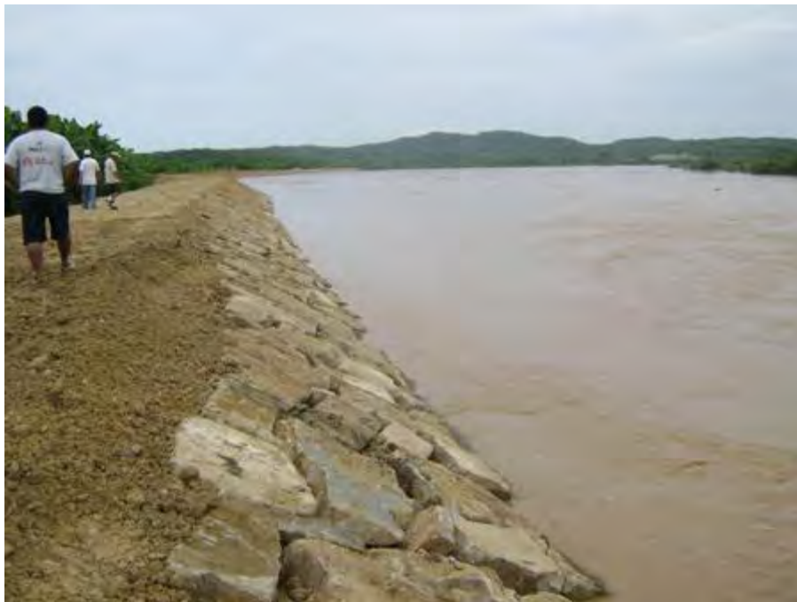
Obra de protección protegida a base de enrocamiento
