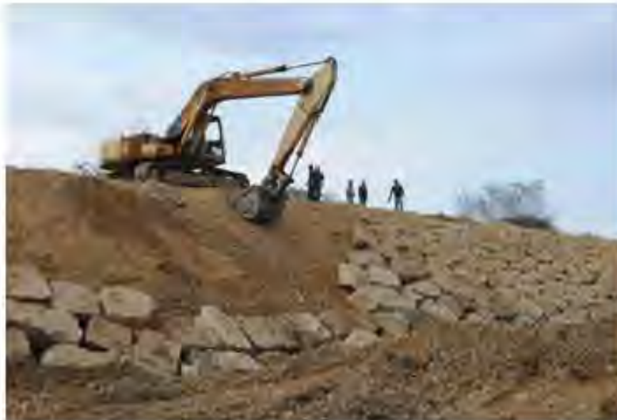
Cuerpo del talud protegida a base de enrocamiento
