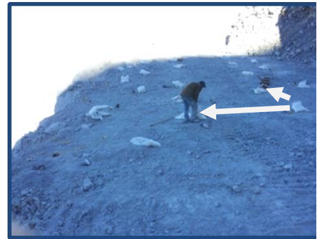
Figura 73. Espaciamento entre filas y barrenos
