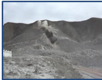
Figura 65. Voladura de Gramol realizada en el banco Norte
