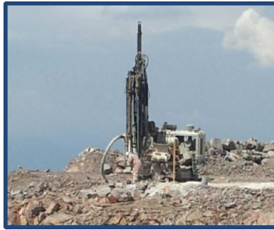
Figura 64. Track drill realizando una barrenación
