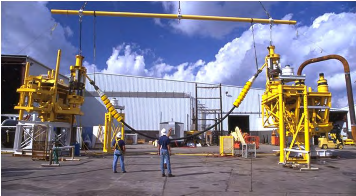
Fig. V. 16. Instalación de un jumper flexible.
