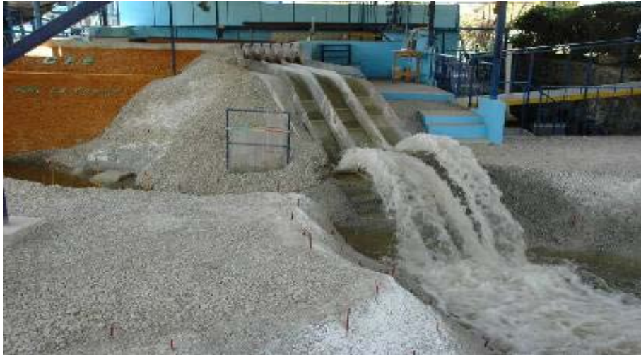
Descarga por los tres canales
