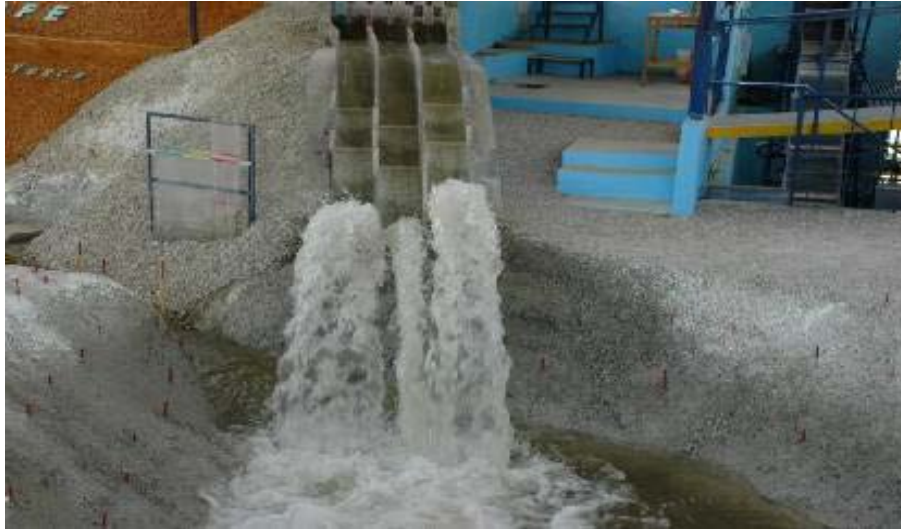
Fotos 6.2 Funcionamiento hidráulico del Vertedor del P.H La Yesca.
