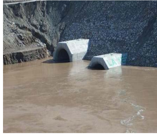
Fotos 3.5 Túneles de desvío de sección portal.
