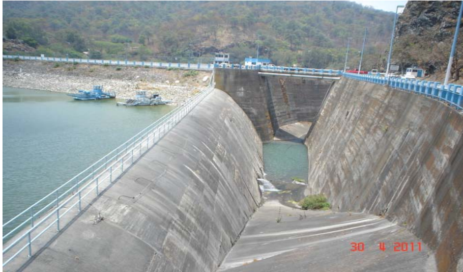
Foto 2.2 Vertedor de canal lateral de la Presa Valle de Bravo, Edo de Méx.
