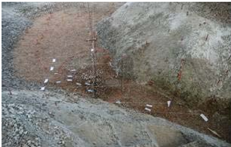
Erosión deposito de los materiales.
