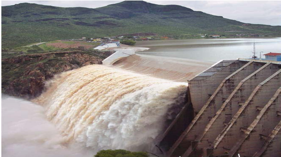
Foto 2.1 Vertedor de caída libre de la Presa Francisco I. Madero (Las Vírgenes), Chis.
