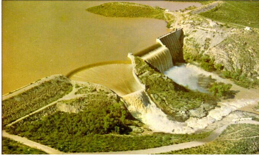
Foto 2.3 Vertedores en abanico y caída libre de la Presa Fco I. Madero (Las Virgenes), Chis.
