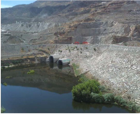
Fotos 3.5 Túneles de desvío de sección portal.
