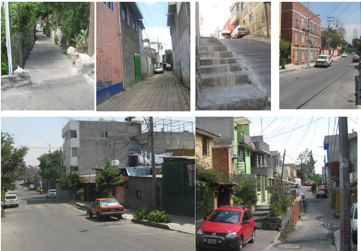
Distintos tipo de vialidades y andadores existentes al interior de la colonia. Fuente: Fotografías propias tomadas durante el recorrido de campo, en 2008.
