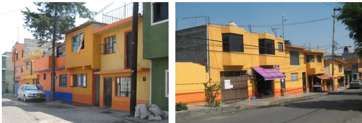
Mejoras en las viviendas (pintura en fachadas) llevadas a cabo con el apoyo del Gobierno de la Ciudad de México. Calle Canauhtli, al centro de la colonia.
