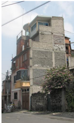
Inmueble sobre Calle Jicote al centro de la colonia.
