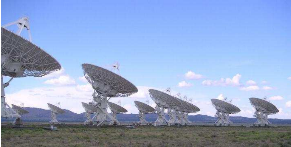
Figura A.1: El VLA, ubicado en las planicies de San Agustín, New Mexico, EUA. Está constituido por 27 platos, cada uno de 25 metros de diámetro que pueden separarse hasta por 36 km, una longitud de onda hasta de \sim 0.7 cm y una resolución de 0.05'' .
