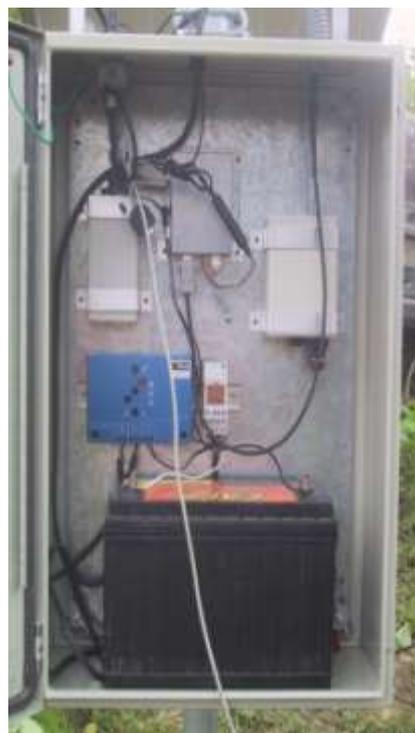
Figura 7. Sistema óptico, de alimentación y de telecomunicación de la estación DOAS. | Fotografía de José Manuel Álvarez Nieves.
