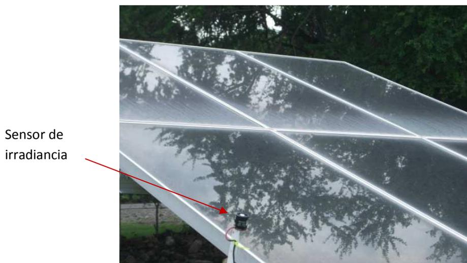
Figura No. 3- 14 Ubicación del sensor de irradiancia en el arreglo fotovoltaico.
