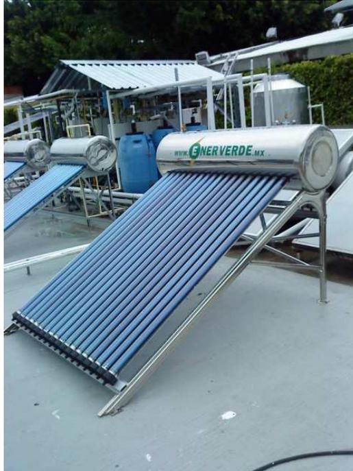
Figura 4.1: Calentador solar de agua de 165 (l) marca Enerverde.
