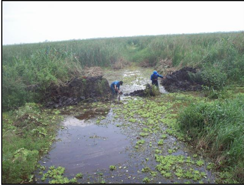
Figura.- 1.9 Foto3 Tirante del agua entre 50 y 70 cm en algunos sondeos.
