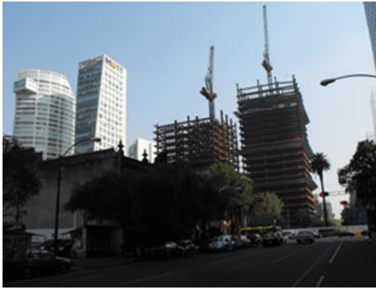
Proyectos en construcción sobre Paseo de la Reforma
