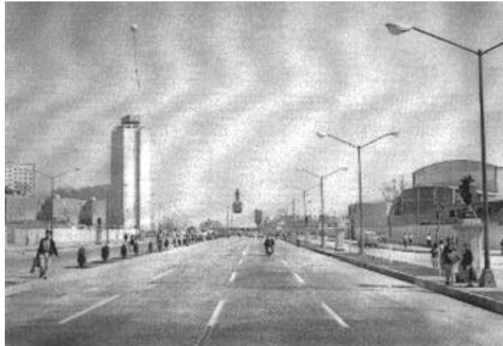
Prolongación norte del Paseo de la Reforma, ca 1965
