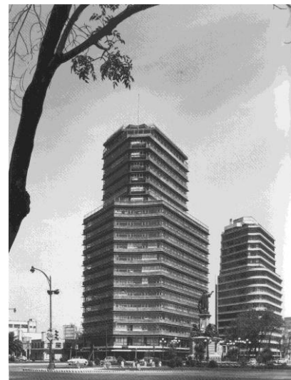
Secretaría de Recursos Hidráulicos y Edificio de Oficinas en calle La Fragua, 1947 y 1948 Fuente: Adrià, Miquel, 2005
