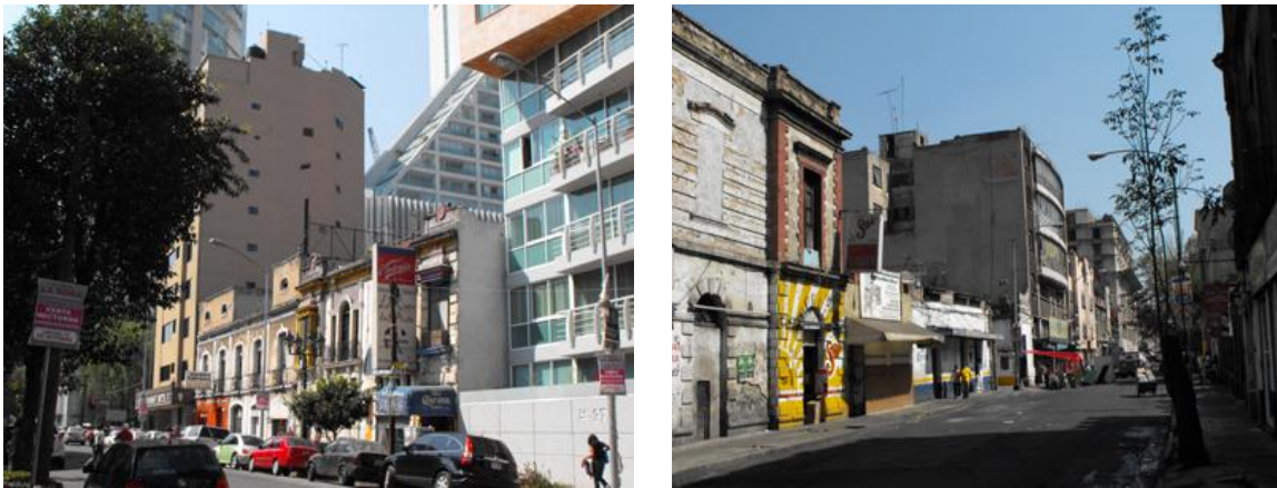
Inmuebles en calles traseras del corredor Paseo de la Reforma: Hamburgo esquina Insurgentes, y Artículo 123 esquina Bucareli. Al fondo se aprecia el desarrollo mixto Reforma 222
