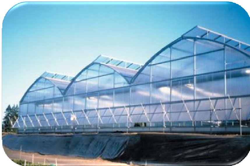
Figura 1.2 Invernadero tipo capilla.
