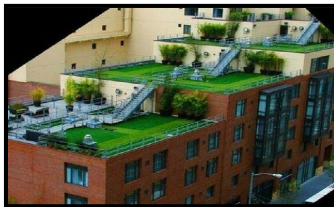
Fig. 4.20 Azotea verde con accesos
