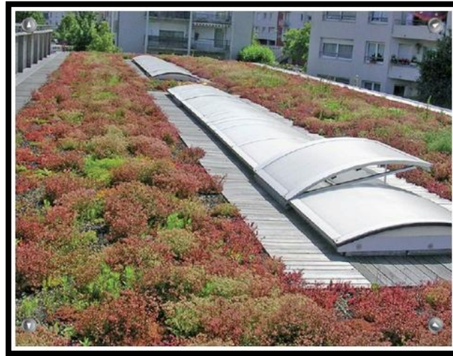
Fig. 4.19 Azotea verde con sistema fotovoltaico
