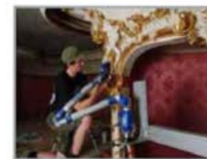
(Fig. 116) Restauración con láser
