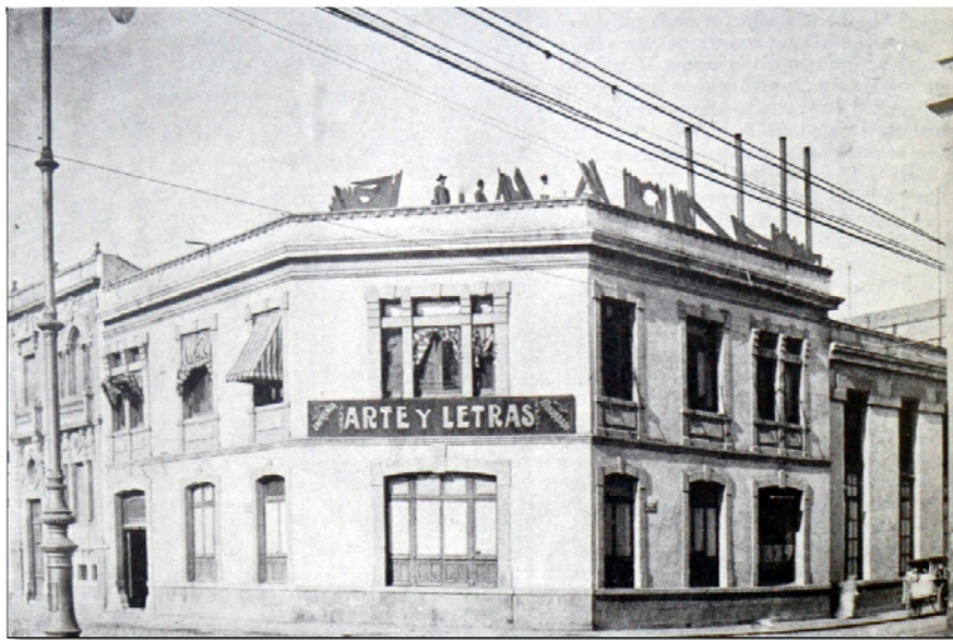
2. Taller de fotograbado Arte y Letras en la Avenida Balderas
