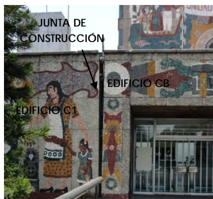
Figura 3.51 Junta de construcción entre el edificio C1 y el edificio CB
