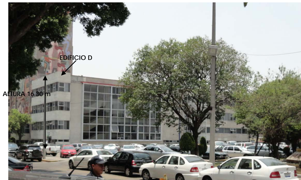
Figura 3.43 Vista lateral del edificio D
