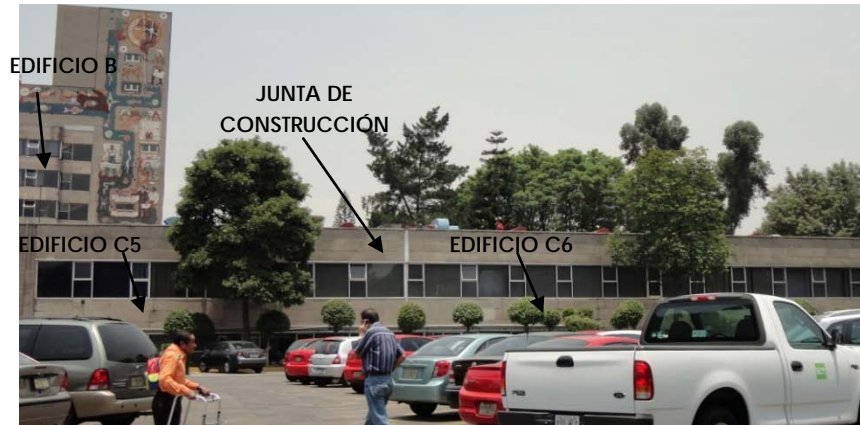
Figura 3.40 Localización de los edificios C5 y C6
