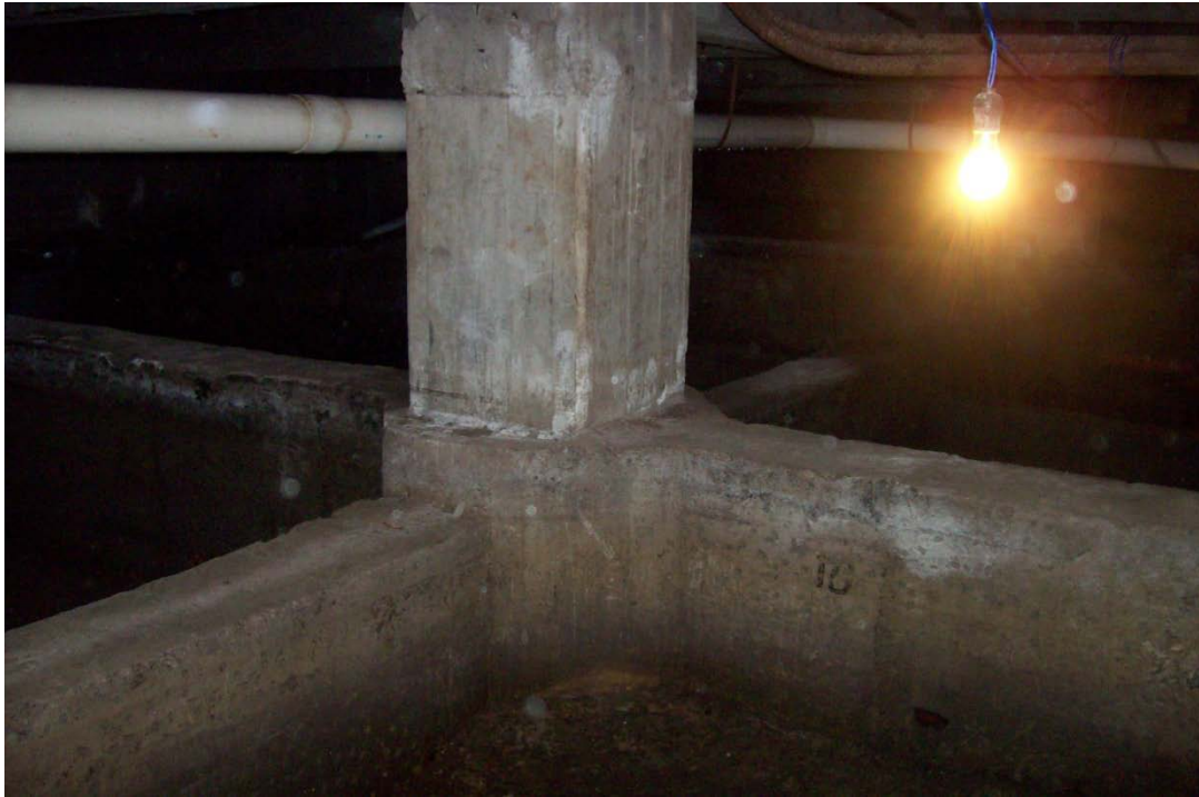
Fotografía 1. Contratraves y columna del cajón de cimentación
