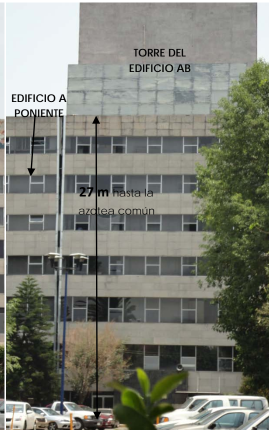
Figura 3.35 Fachada posterior del edificio AB
