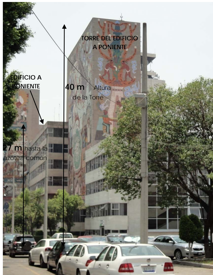
Figura 3.28 Configuración del edificio A Poniente
