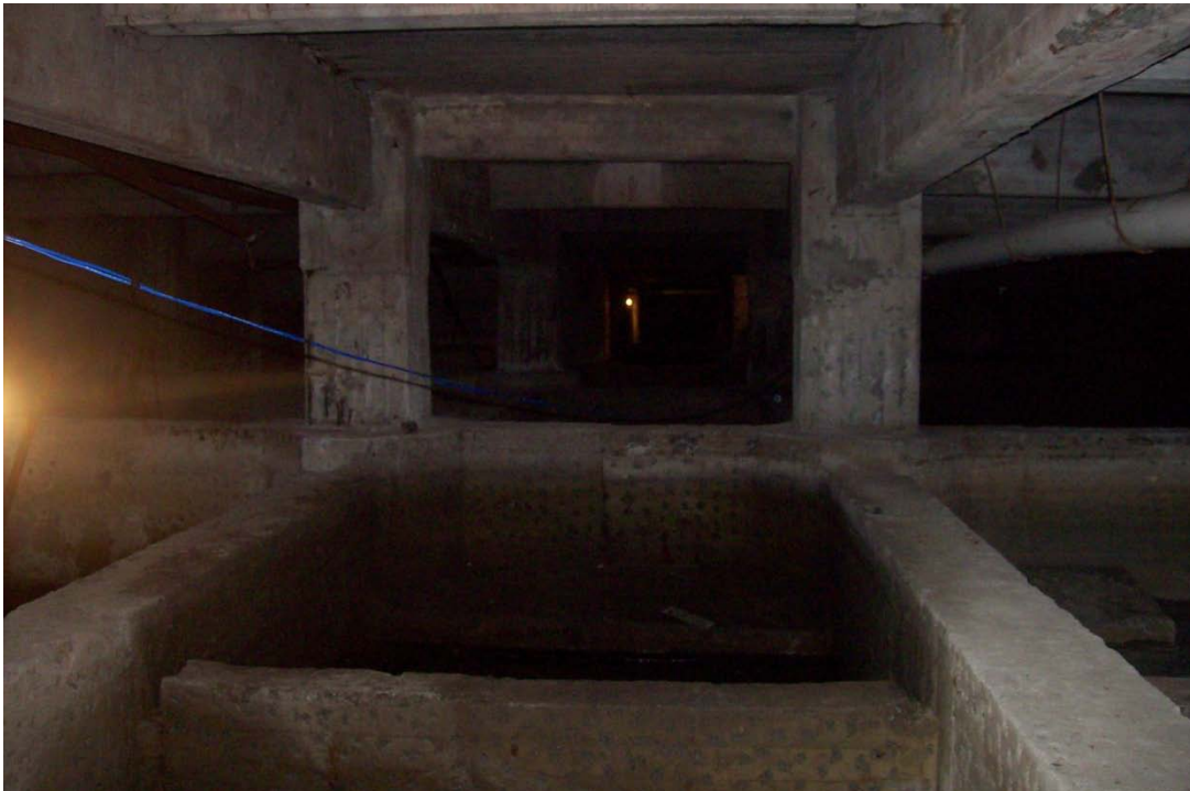
Fotografía 2. Vista general del cajón de cimentación del edificio D
