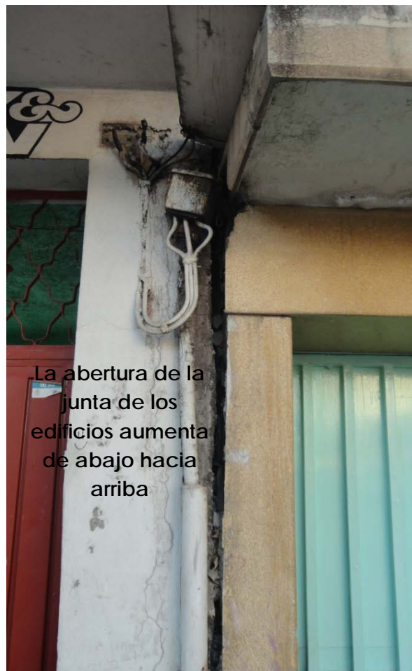
Figura 2.11 Grieta de un edificio sobre paseo de la reforma, México, D.F.
