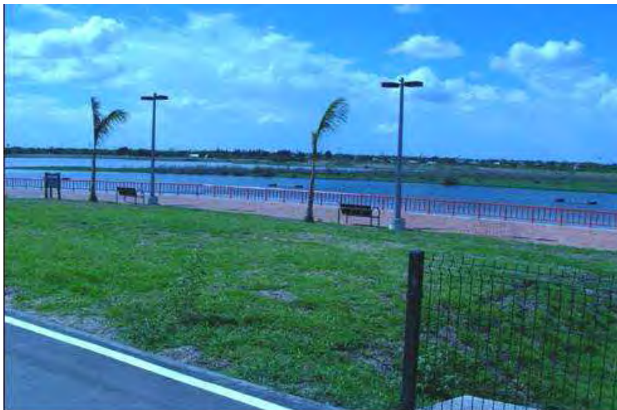
INFRAESTRUCURA ACTUAL EN FUNCIONAMIENTO, DENTRO DE LA ZONA INVADIDA
