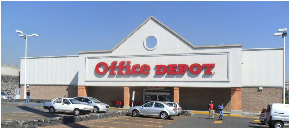
Figura 4-3. Vista de la fachada del inmueble analizado
