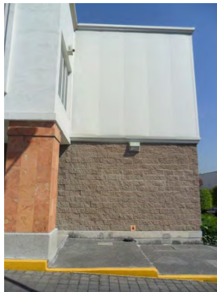
Figura 4-1. Vista del arreglo del panel en fachada del inmueble
