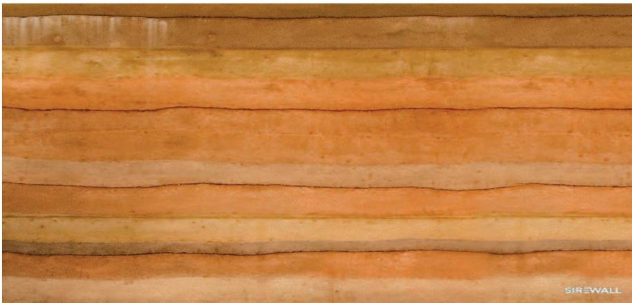
Ilustración 4: Los muros de tierra se compactan por capas, es posible variar la tonalidad de cada capa, de esta manera se puede simular el mismo degradado que vemos en las tonalidades del azúcar a través del proceso de refinación.
