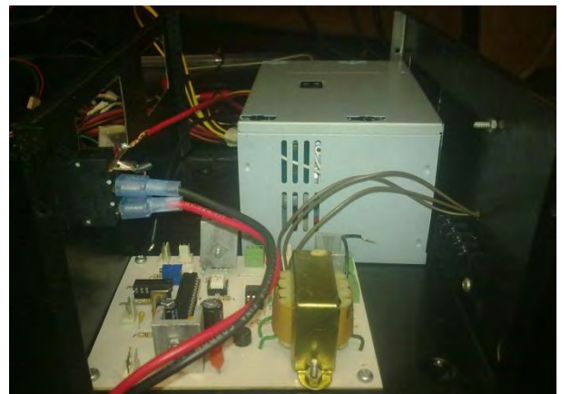
Figura A-2. Vista lateral interna del sistema de control.
