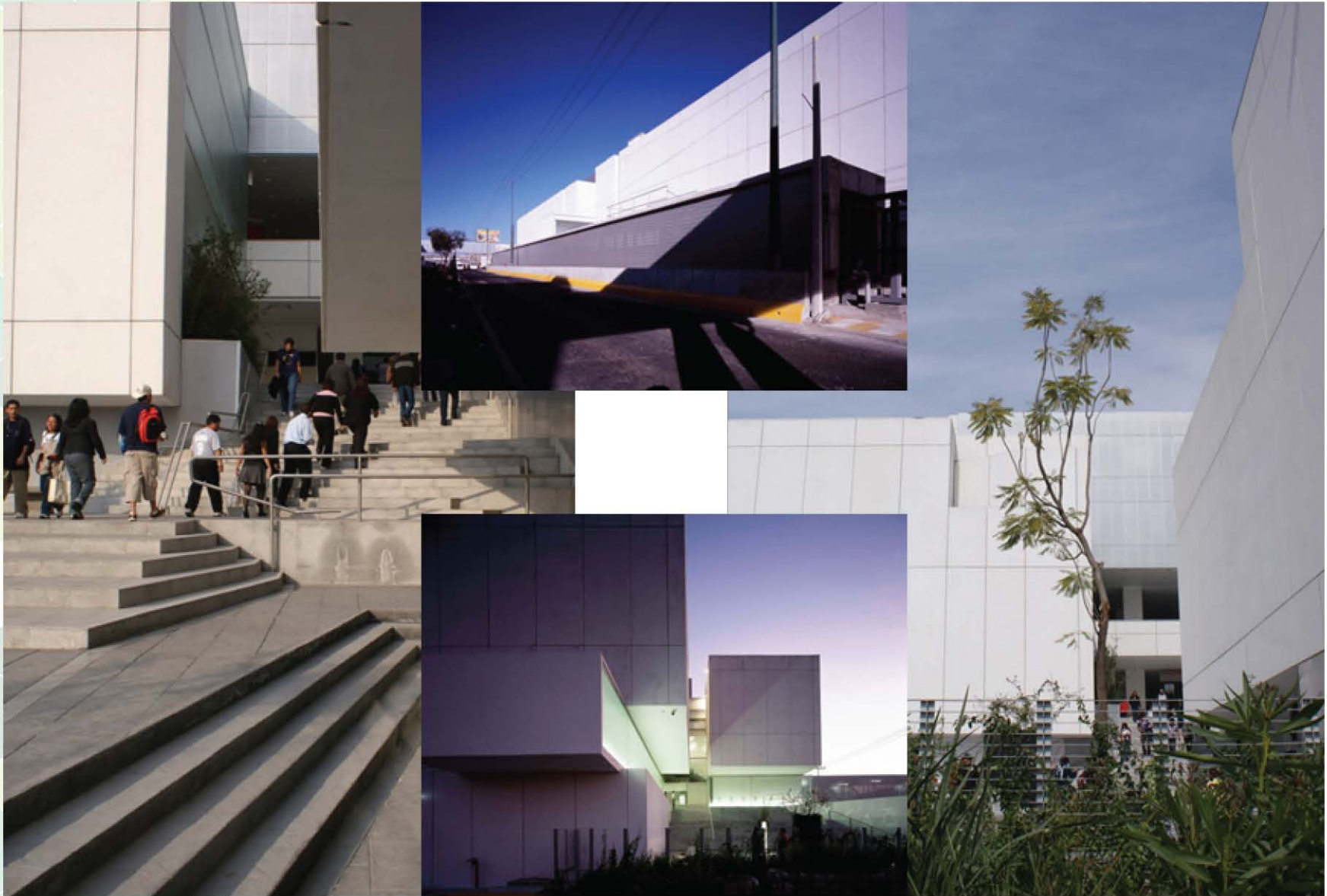
Ilustración 40. Diferentes vistas del CETRAM Ciudad Azteca (MEXIPUERTO).
