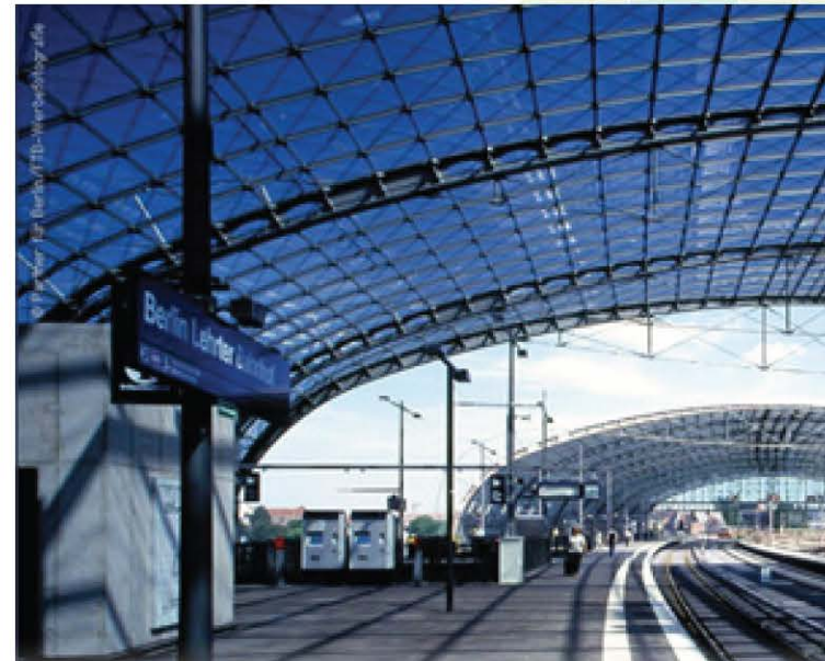
Ilustración 49. Vista interior andenes.
