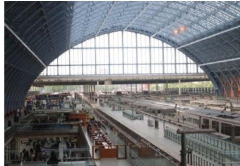
Ilustración 48. Vista interior andenes.
