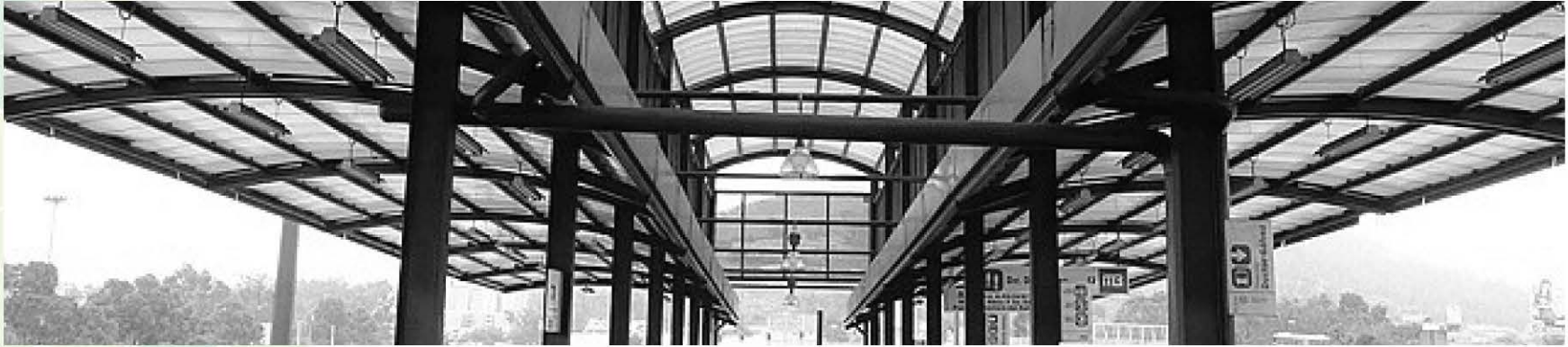
Ilustración 20. Estructura de la cubierta Terminal del Metrobus Indios Verdes.
