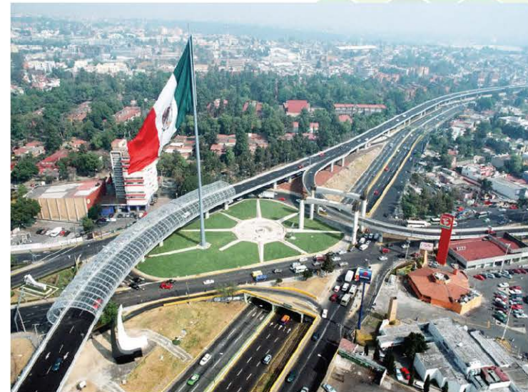
Ilustración 11. Segundo piso del Periférico.
