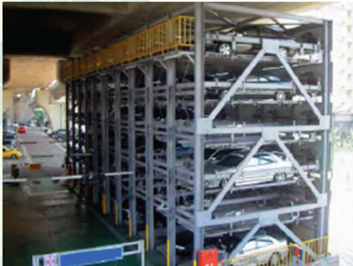
Ilustración 51. Estacionamiento en superficie con sistema automatizado.
