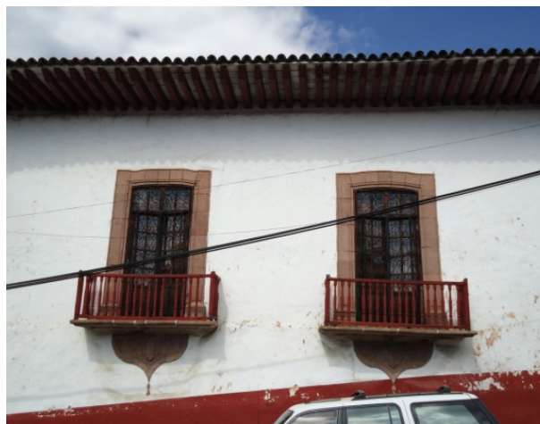
Imagen 55. Guardamalleta de una casa en la calle de las Alcantarillas. Fotografía: Carlos Alfonso Ledesma Ibarra, 2010.
