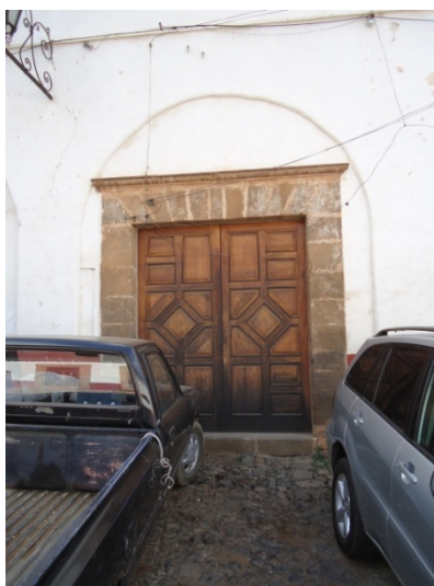
Imagen 30. Entrada al Colegio de San Ignacio de Loyola desde la calle de las Alcantarillas.
