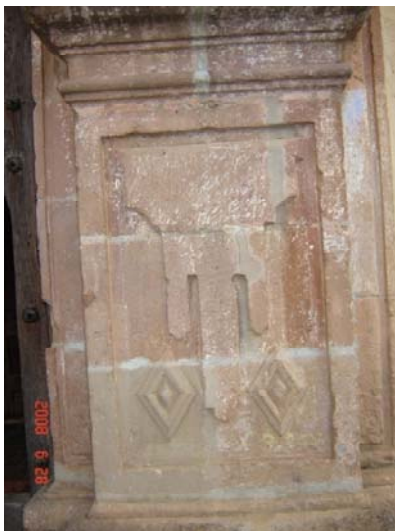
Imagen 56. Detalle de la pilastra de la fachada del Templo de San Ignacio de Loyola.
