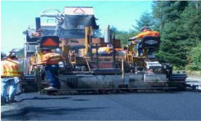
Fig. V.1.- Pavimentadora en operación (Fuente: Constructora CUCSA).
