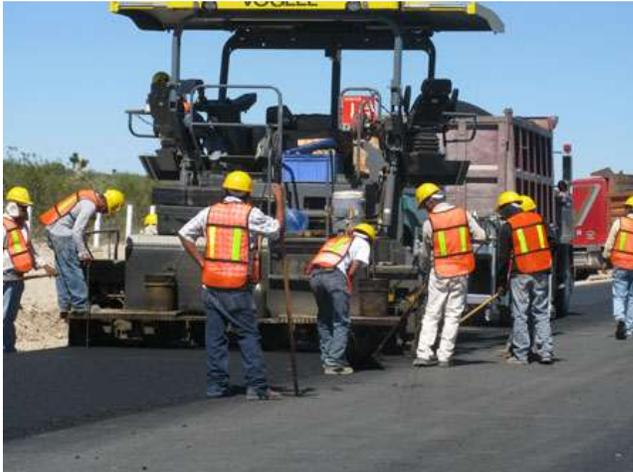
Fig.I.2.- Trabajos de conservación de carreteras mediante tendido de sobre carpeta asfáltica (Fuente: SCT).
