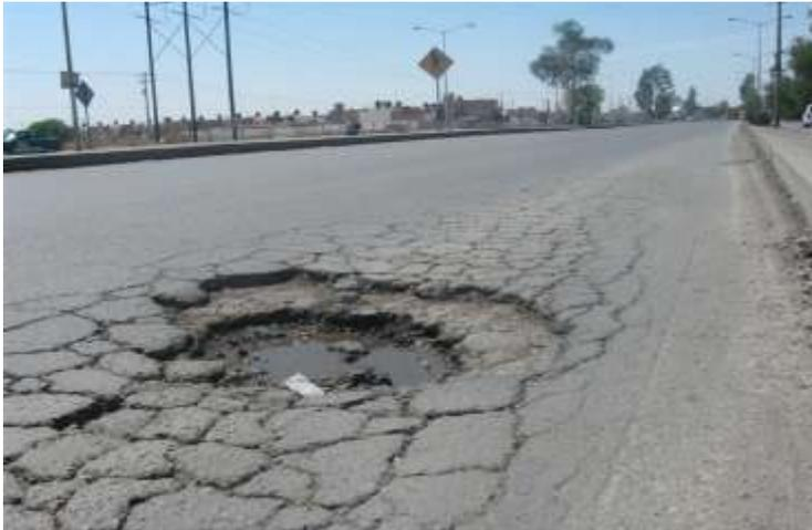
Fig.I.5.- Grietas, baches y desgranamiento de un pavimento (Fuente: SCT).
