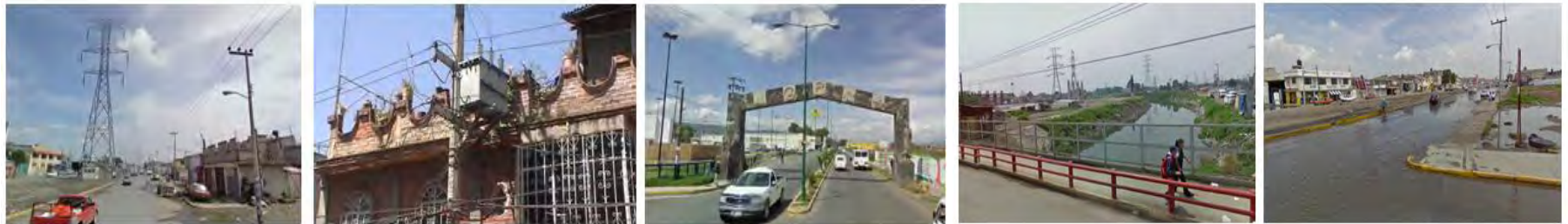
Imágenes que muestran la infraestructura eléctrica, torres de alta tensión y alumbrado público. También el canal de aguas negras de la compañía, y una zona con problemas de encharcamiento.
