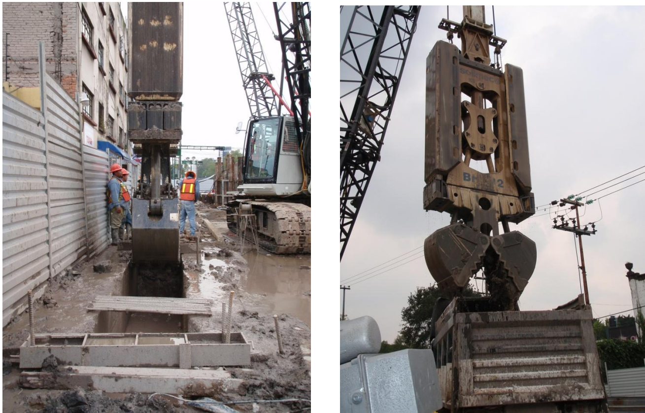
Fig. V.3, Muro prefabricado con avance modular
