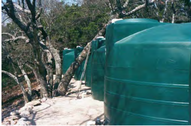
Figura 26. Tanques de polipropileno. Fuente: The Texas Manual on Rainwater Harvesting.
