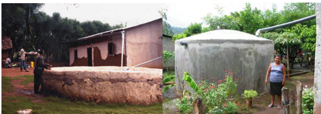
Figura 15. Sistemas de captación de agua de lluvia en techos de lámina, conducción y almacenamiento. Nicaragua.
