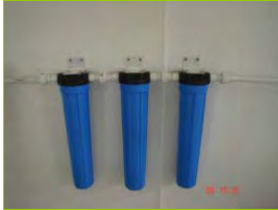
Figura 41. Microfiltros pulidores de 20, 10 y 5 micras respectivamente.
