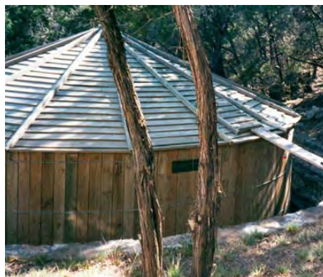
Figura 29. Tanque de madera en Texas. Fuente: The Texas Manual on Rainwater Harvesting.
