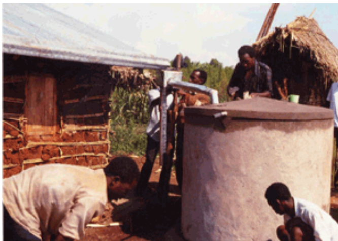
Figura 14. Cisterna recolectora de agua de lluvia en Honduras. Fuente: CIDECALLI - CP
