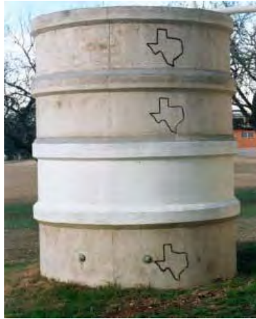
Figura 28. Tanque fabricado con anillos de concreto apilados.
