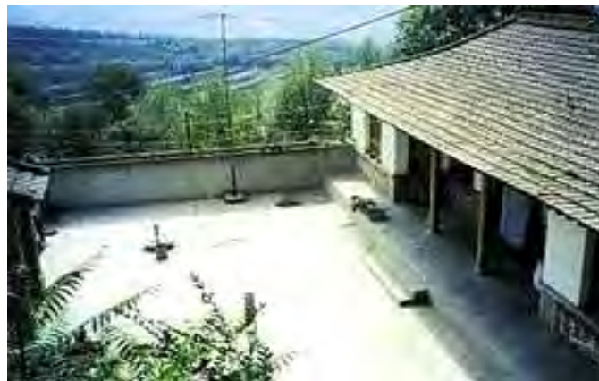
Figura 7. El agua es captada en el techo, se almacena bajo el piso y se extrae mediante una bomba de mano. Fuente: www.unep.or.jp
