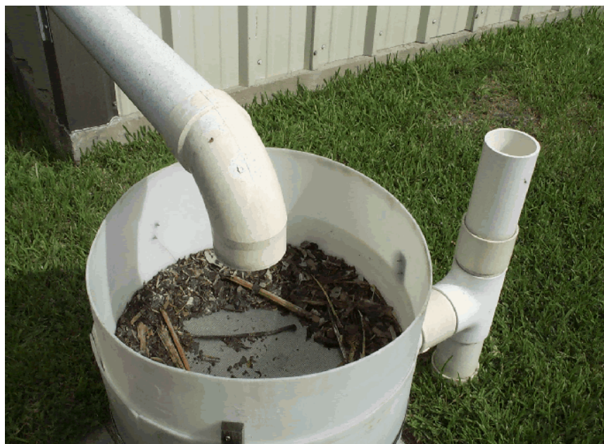
Figura 33. Trampa de basura para las primeras lluvias. Fuente CIDECALLI – CP.
