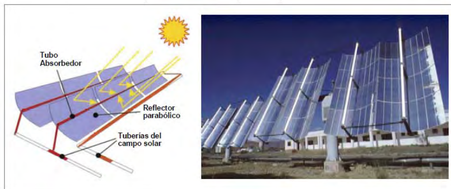
Figura 50. PTC con seguimiento en un eje (izquierda) y PTC con seguimiento en dos ejes (derecha), para aplicaciones en fotocátalisis. (PSA, España).
