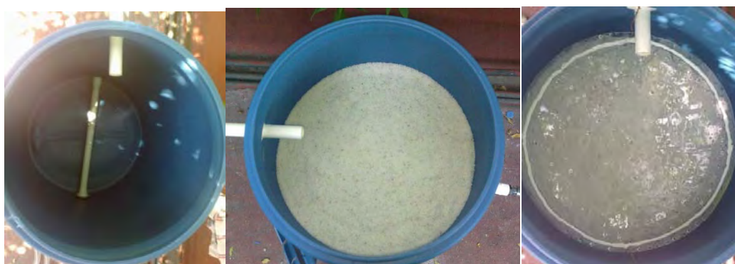
Figura 73. Construcción del filtro de arena.
