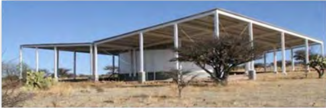
Figura 20. Techo cuenca en la comunidad de Tecongo, Aguascalientes (Anaya, 2007).
