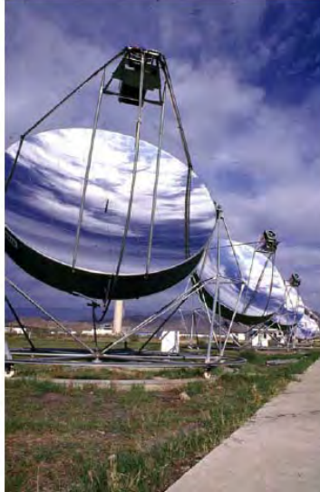
Figura 49. Colector solar de alta concentración. (PSA, España).
