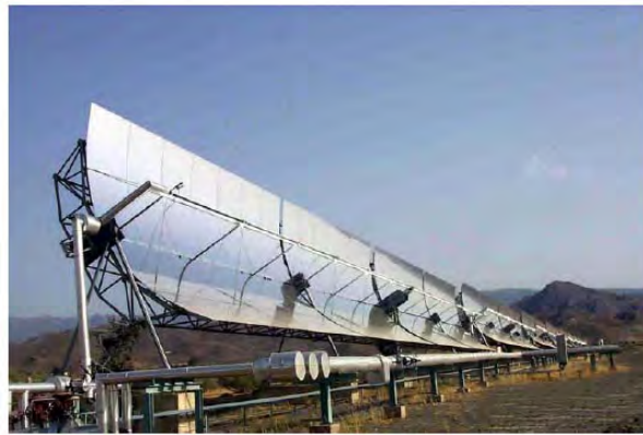
Figura 48. Colector solar de media concentración PTC. (Plataforma Solar de Almería)
