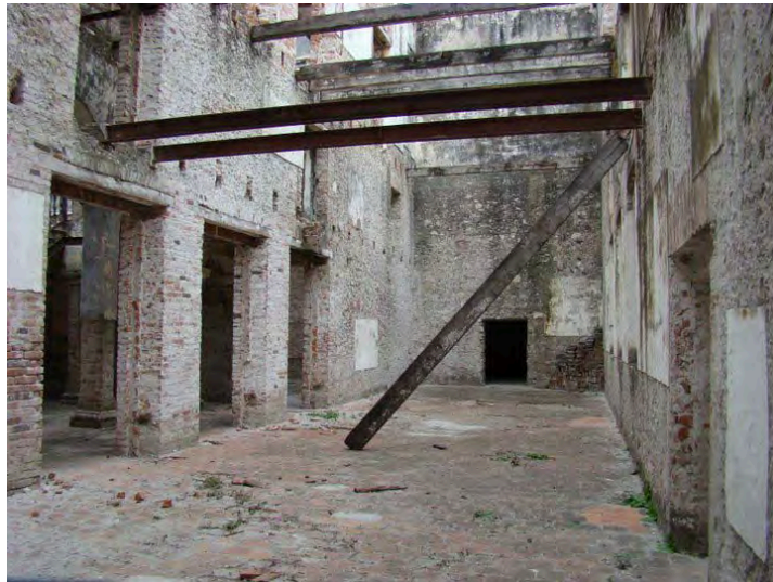
FIGURA 162. Grandes galeras de la antigua fábrica perfectas para amplios lofts.
