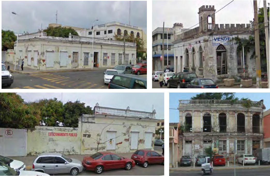
FIGURA 166. Edificios vecinos de La Prueba que actualmente se encuentran en abandono o desuso, candidatos ideales para transformarse en vivienda.
