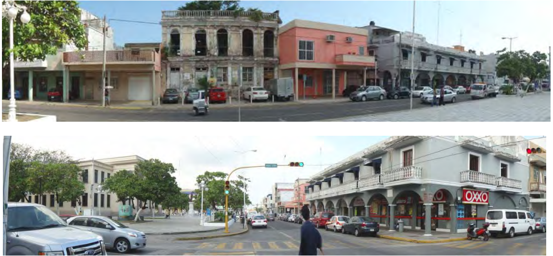
FIGURA 69 Y FIGURA 70. En las figuras superiores, panorámicas de la calle Francisco I. Madero, se observan edificios en desuso y/o estado de abandono, además de la reutilización de un edificio para comercio.
