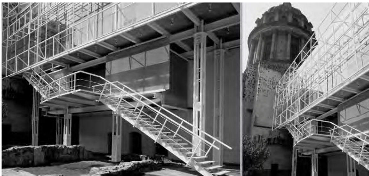
FIGURA 36 Y FIGURA 37. Intervención `reversible´ en el patio del Antiguo Convento de Santa Teresa La Antigua.
