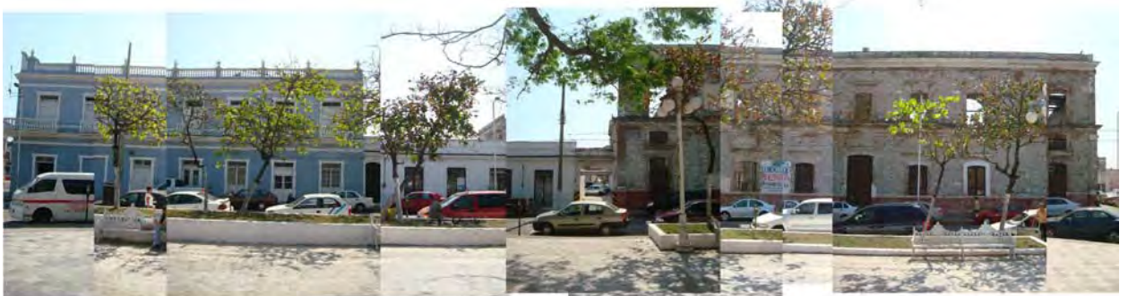
FIGURA 71. Deterioro de "La Prueba" en fachada de Lerdo.
