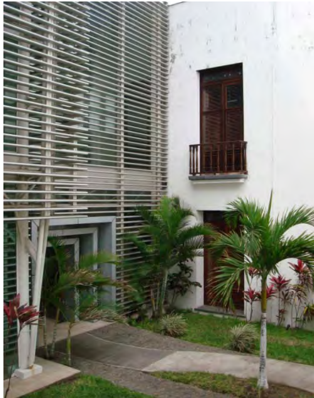
FIGURA 44. Contraste entre el edificio antiguo y el nuevo.
