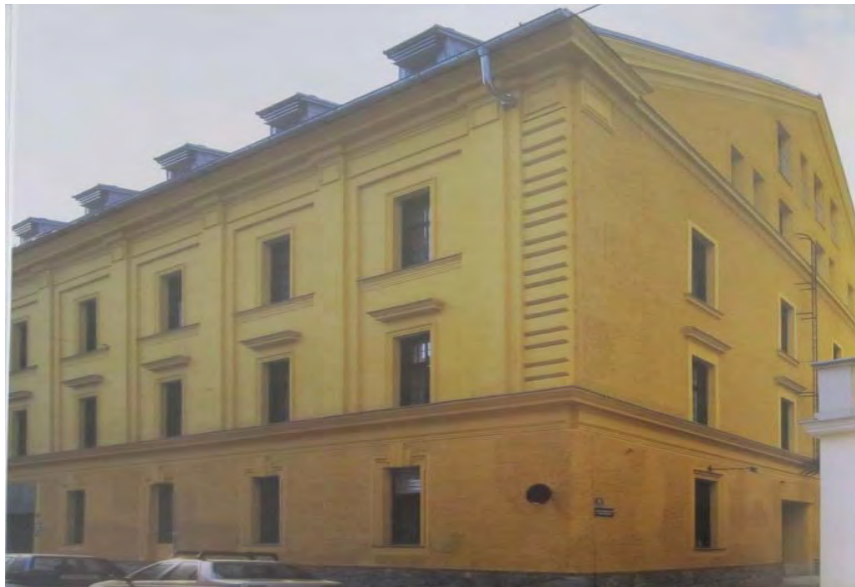
FIGURA 30. Fachada sur del edificio, parte antigua.
