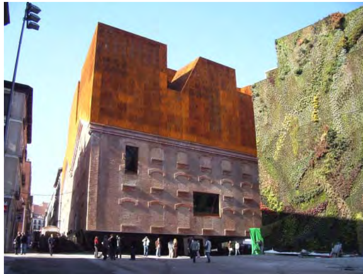
FIGURA 26. Propuesta de Herzog & de Meuron para el Caixa Forum de Madrid. Reutilización de antiguo edificio industrial de finales del siglo XIX.
