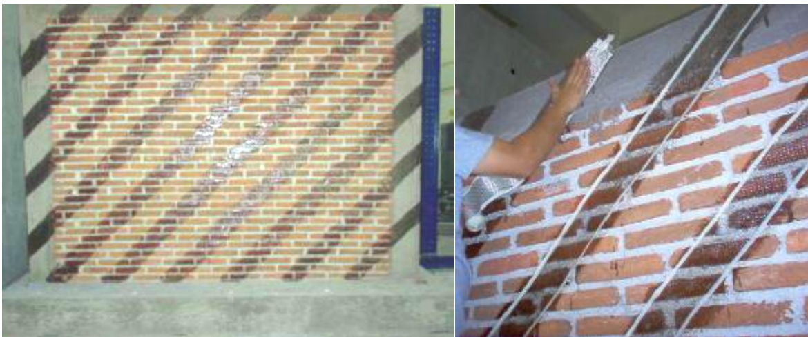
Figura 3.8 Muros de mampostería con fibra de vidrio (Fuente: Velázquez et al., 2007)
