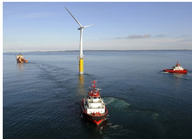
(b) Hywind de SIEMENS(2300 kW)
