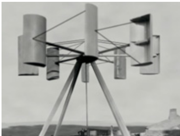
(a) Aerogenerador de Blyth(12 kW), 1887
