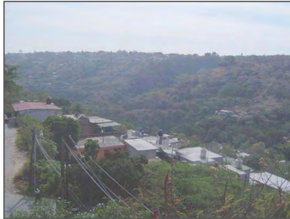
1. Vista desde el primer puente de la carretera federal pasando la glorieta de "el polvorín".
