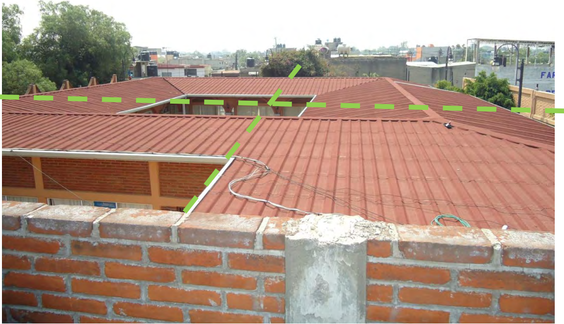
Vista de cubiertas. (Sistema Losacero)
