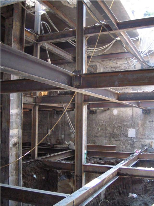
Reforma y Berna, D.F. Muro Milán apuntalado con las traves de entrepiso, excavación a 14.0 m.
