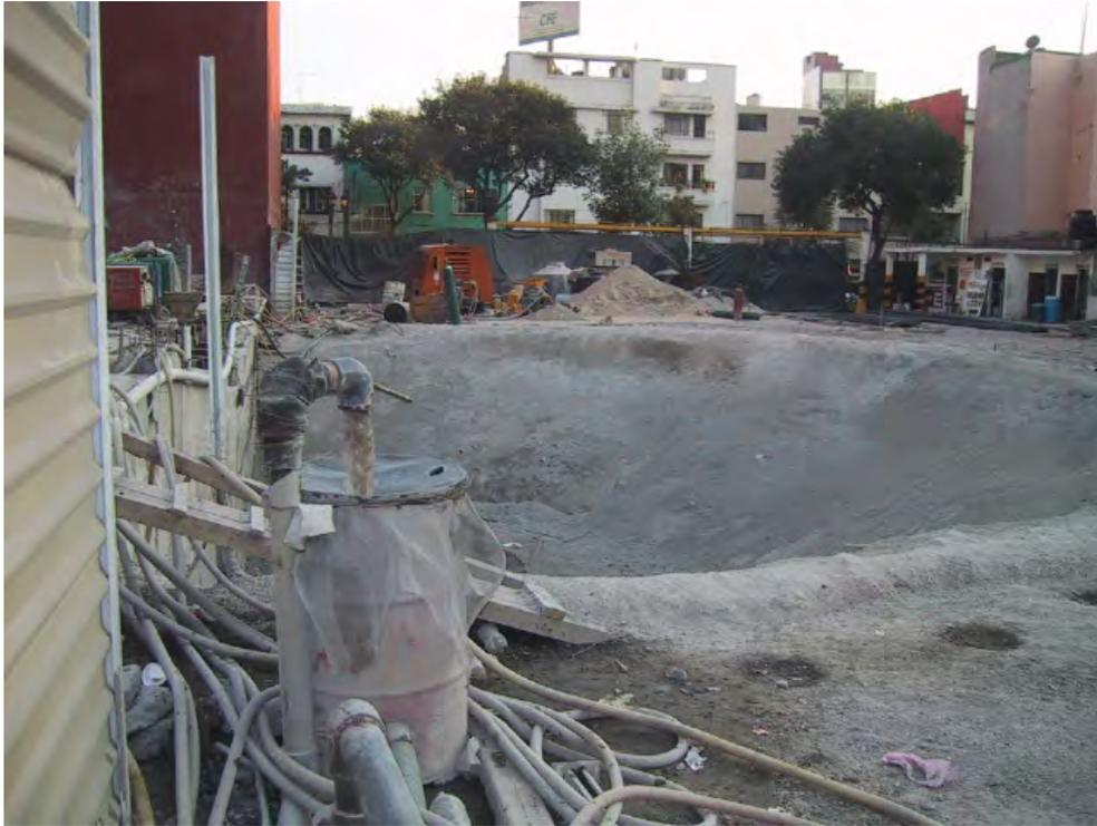
Foto 5.19. Estabilización completa de la superficie de falla utilizando la membrana de concreto lanzado, reforzada con una malla electrosoldada.
