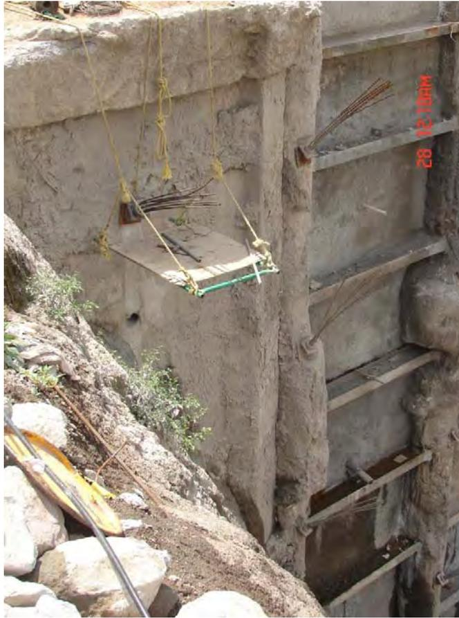
Dakota y Arkansas, D.F. Muro Berlín con 5 niveles de anclas postensadas, excavación a 14.0 m.
