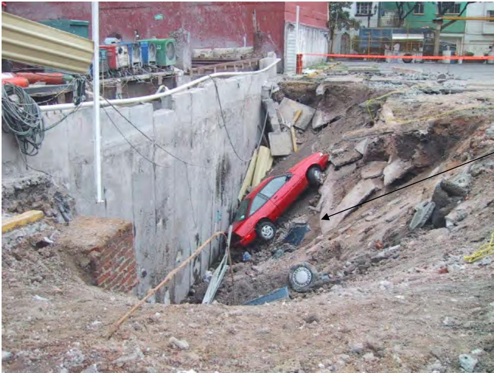
Fig 5.6. Se muestra la zona de falla que se presentó en el terreno del estacionamiento que colida al poniente (Fig 5.1); las tabletas además de asentarse se desplazaron ligeramente hacia el oriente.
