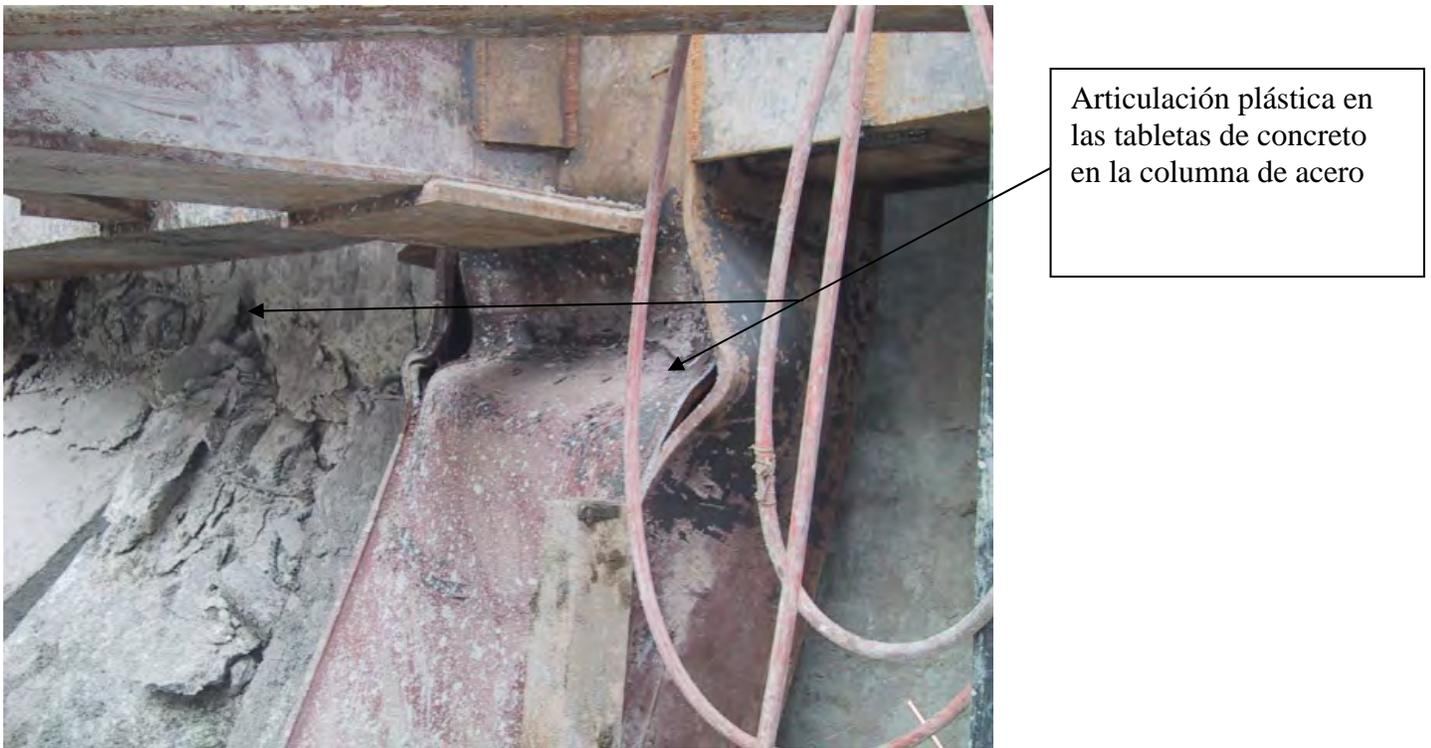
Fig 5.5. Se muestra la plastificación de la ataguía de concreto y de la columna A-3 al nivel del último puntal a una profundidad de 6,95 m, su localización en planta aparece en la Fig 5.1; lo que corresponde plenamente con los criterios de Zeevaert y Tamez.
