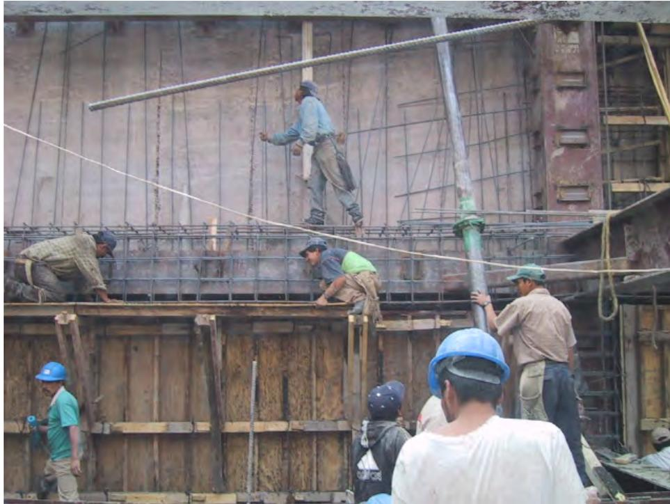
Fig 5.21. Otra vista del colado del muro perimetral en la crujía contigua a la zona de falla.
