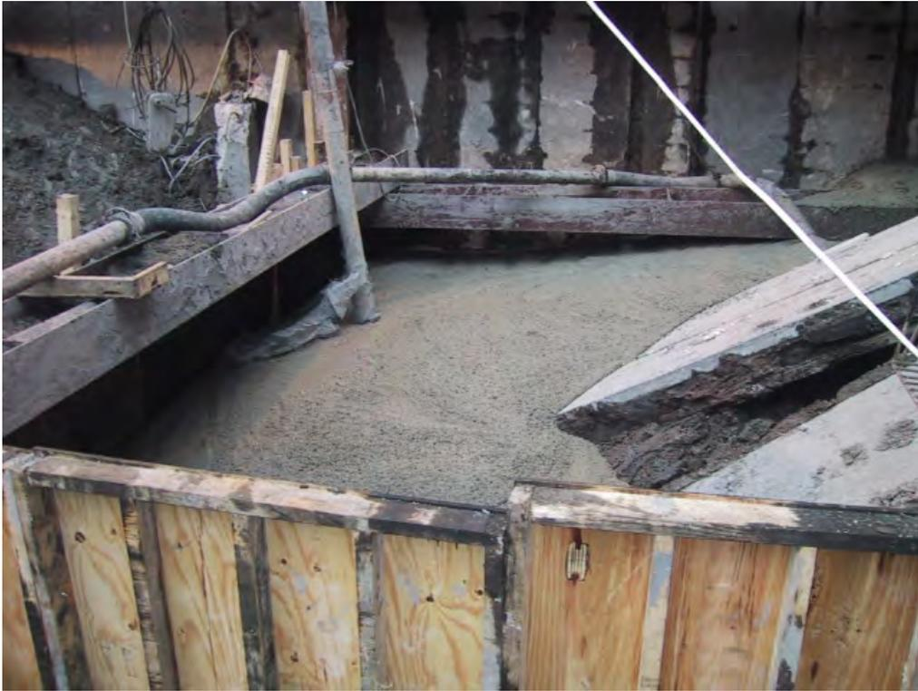
Fig 5.11. Vista en detalle del concreto en la zona de la falla; el lodo del fondo se dejó ahí, al igual que la se dejaron las patas falladas de las tabletas de concreto.
