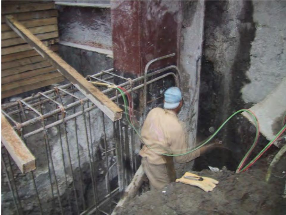
Foto 5.17. Arreglos en la cimentación para colar las contratraves y columnas de concreto que envuelven las correspondientes de acero.
