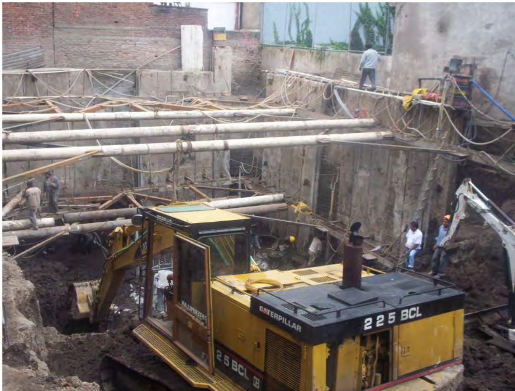
Arquímedes No. 25, Polanco, D.F. Muro prefabricado con 2 niveles de puntales para una excavación de 10.0 m de profundidad.
