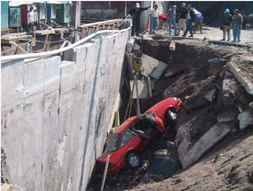
Fig 5.12. Retiro de los vehículos para iniciar los trabajos de estabilización de la zona de falla.
