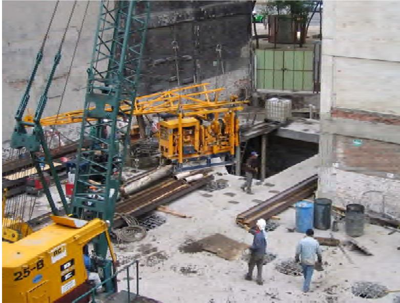
Fig 4.6. Equipos y almacenamiento de material en la losa de PB
