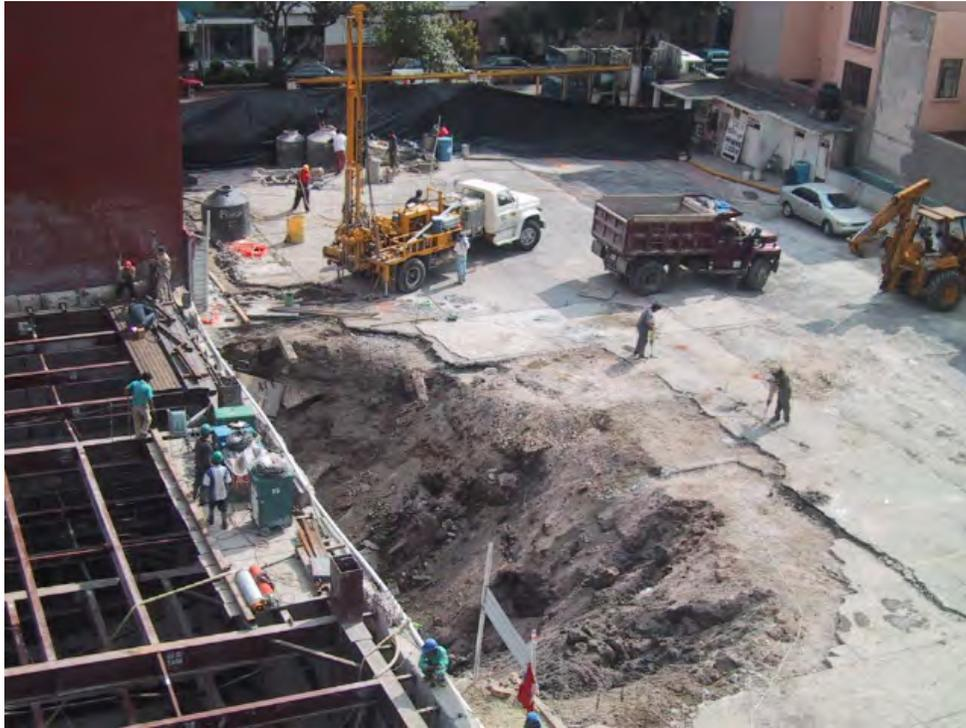
Fig 5.13. Construcción de pantalla impermeable a lo largo de la traza de la superficie de falla para controlar el flujo de agua hacia la excavación y para evitar que, ello indujera asentamientos en las casas colindantes al sur (Fig 5.1). Se observa a la perforadora realizando uno de los pozos de inyección, que se espaciaron a cada 50 cm, alcanzando una profundidad de 20,0 m
