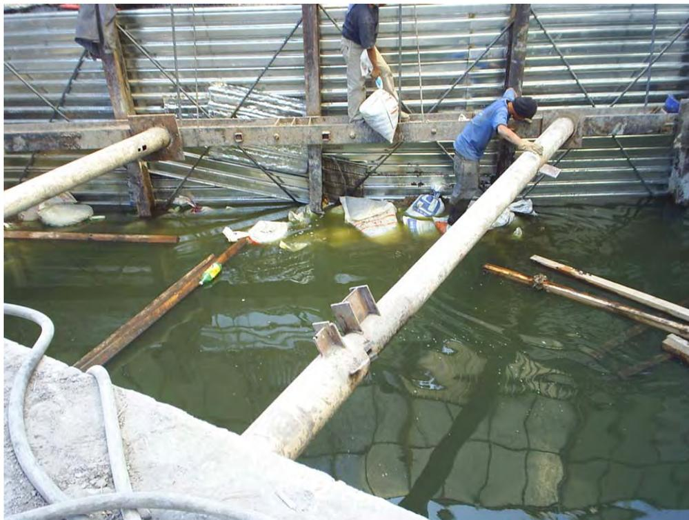
Fig 4.11 Inundación del área de excavación contigua a la lateral de reforma, provocada por fugas en el colector y tubería de agua potable, situadas en la banqueta.
