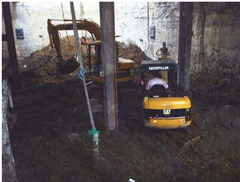
Fig 4.7 Mini-retroexcavadoras realizando la excavación
