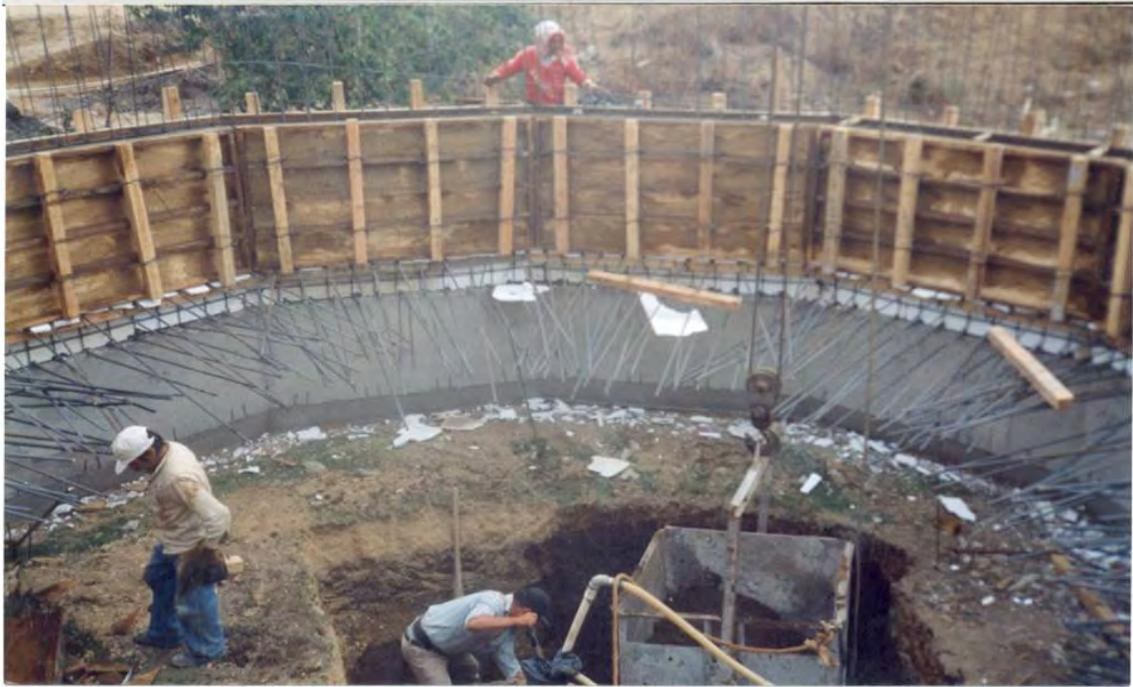
Chalco, Edo. de México. Pozo indio para una excavación de 13.0 m de profundidad.
