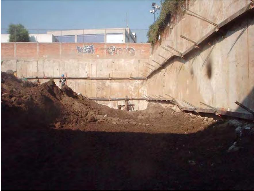
EBC Tlalnepantla, Cerro de las Campanas, Los Pirules, Edo. de México. Muro Milán prefabricado con 2 niveles de anclas postensadas para una excavación de 9.0 m de profundidad.
