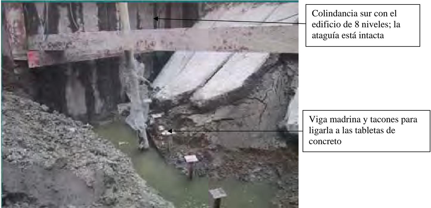
Fig 5.4. Detalle de la colindancia sur y de la punta de las piezas de concreto; al centro se distingue uno de los pozos de bombeo eyector y una de las vigas mdrinas con los tacones para sujetar las tabletas.
