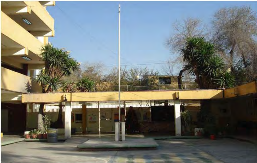
Foto 2. Entrada de la escuela, vista desde adentro
