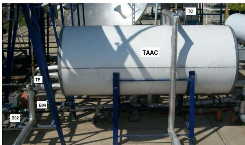
Fig. 4.41 Vista del tanque de almacenamiento de agua caliente.
