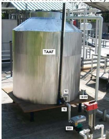
Fig. 4.43 Vista del subsistema de disipación de calor.
