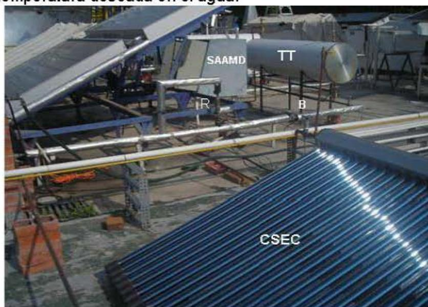
Figura 2. Sistema de calentamiento solar en circuito hidráulico cerrado.
