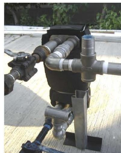
Fig. J1. Configuración de conexión del evaporador
