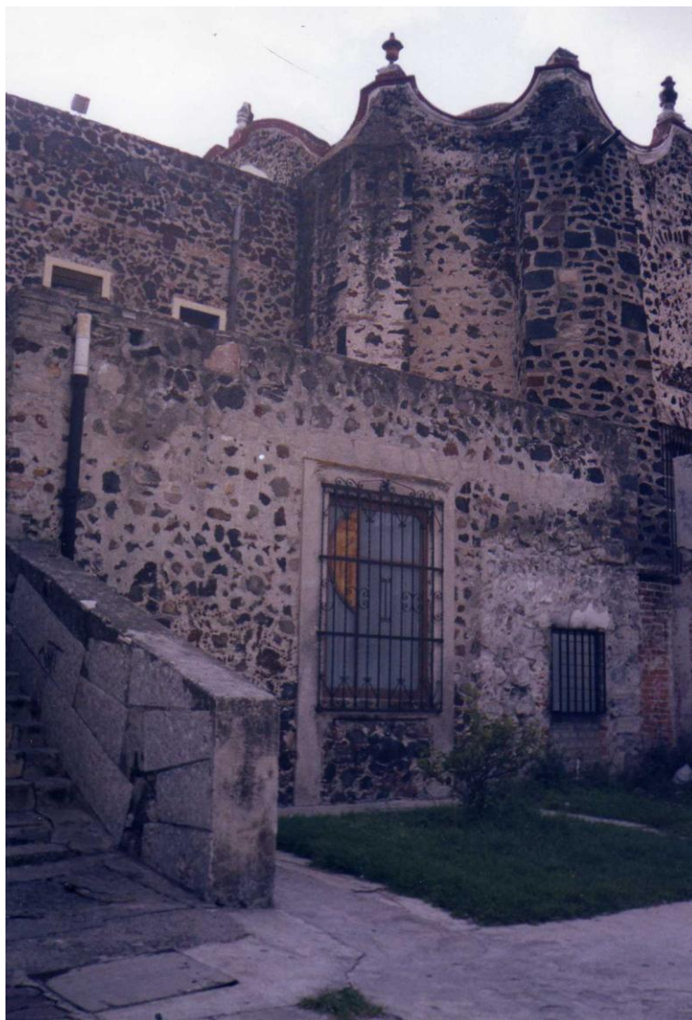
Vista lateral de templo y ex convento de San Matías. Foto: Dalia Cárdenas.
