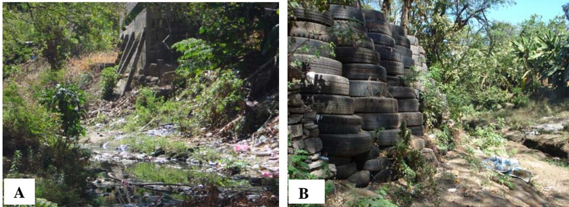
Figura 6.11. **A - B.** Reforzamiento de los muros con vigas de concreto y neumáticos.
