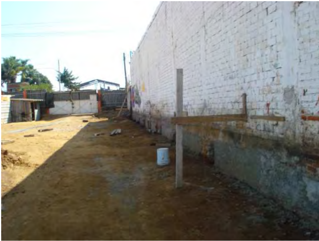
3.5 Nivel del terreno natural mostrado con tablas e hilo.
