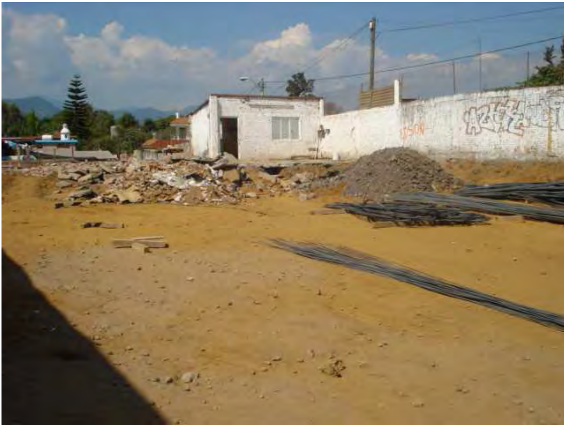
Imagen 3.4 Fachada del predio antes de comenzada la excavación.
