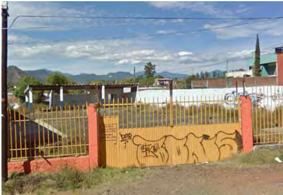
Imagen 3.3 Fachada del predio antes de comenzada la excavación.
