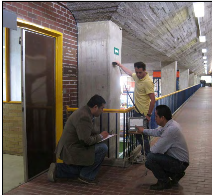
IMAGEN 3.1. LEVANTAMIENTO TOPOGRÁFICO Y OBTENCIÓN DE ACERO DE REFUERZO COLUMNAS (1)
