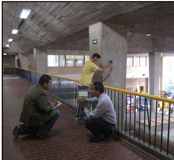
IMAGEN 3.2. LEVANTAMIENTO TOPOGRÁFICO Y OBTENCIÓN DE ACERO DE REFUERZO COLUMNAS (2)
