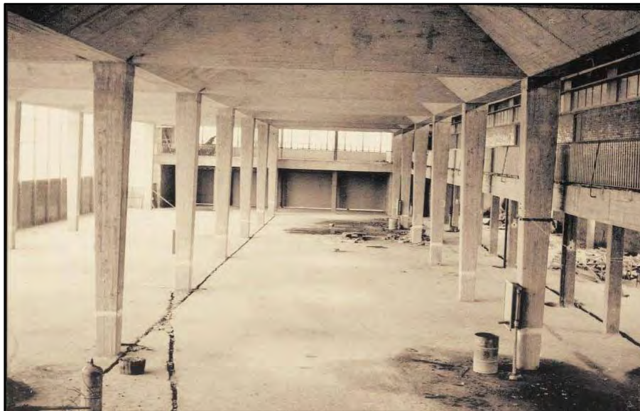
IMAGEN 2.1. ESTRUCTURA DE LABORATORIOS EN SU CONSTRUCCIÓN, FACULTAD DE INGENIERÍA.
