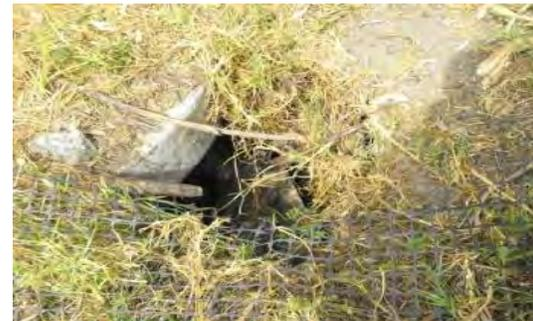
Fotografía 6. Hundimiento en la superficie del terreno junto al él se denota una Oquedad y Hundimiento de una profundidad de 1.20 m, él cual ha sido relleno de basura y madera
