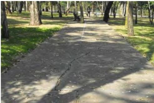
Fotografía 5. Se observa que la loza ésta completamente rota a los costados del camino, también presenta pequeños hundimientos diferenciales de 3cm a 6 cm de profundidad.
