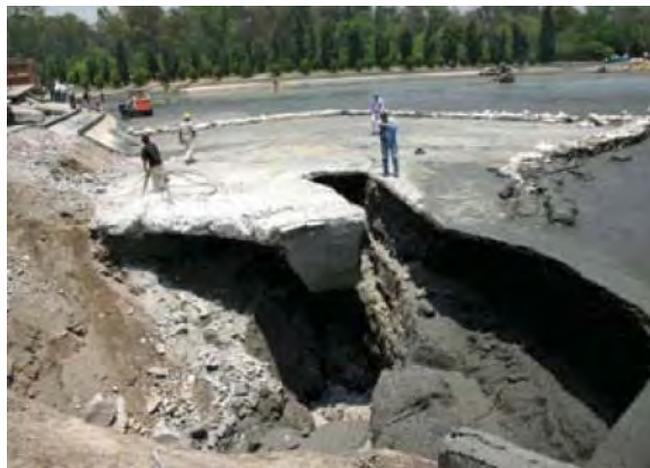
Fotografía 11. Dimensión que alcanzó la fisura por la presión del agua.
