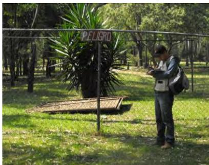
Fotografía 7. Hundimiento relleno y resguardado con malla ciclónica, con la finalidad de evitar accidentes.
