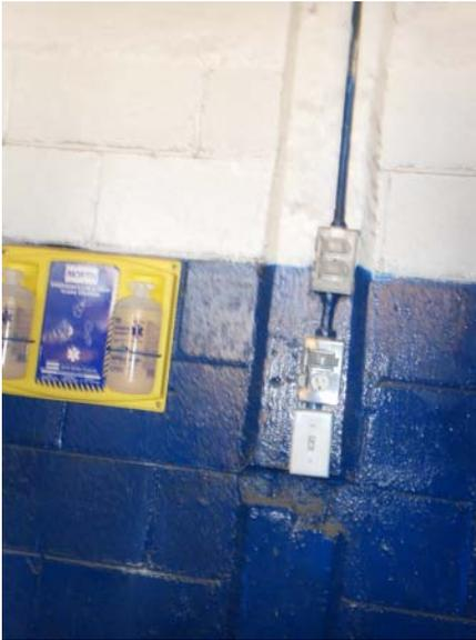
**Fig. 3.15 contactos nuevos con tapa tipo intemperie y apagadores**
