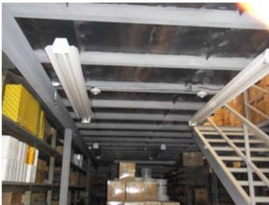
**Fig. 3.22 a detectores de movimiento de 360°**
