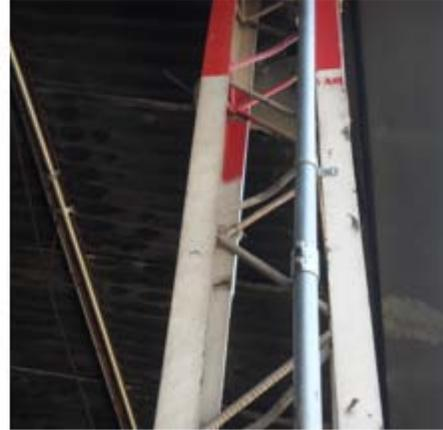
**Fig. 3.21 a y 3.21 b medios de sujeción empleados para soportar las tuberías**
