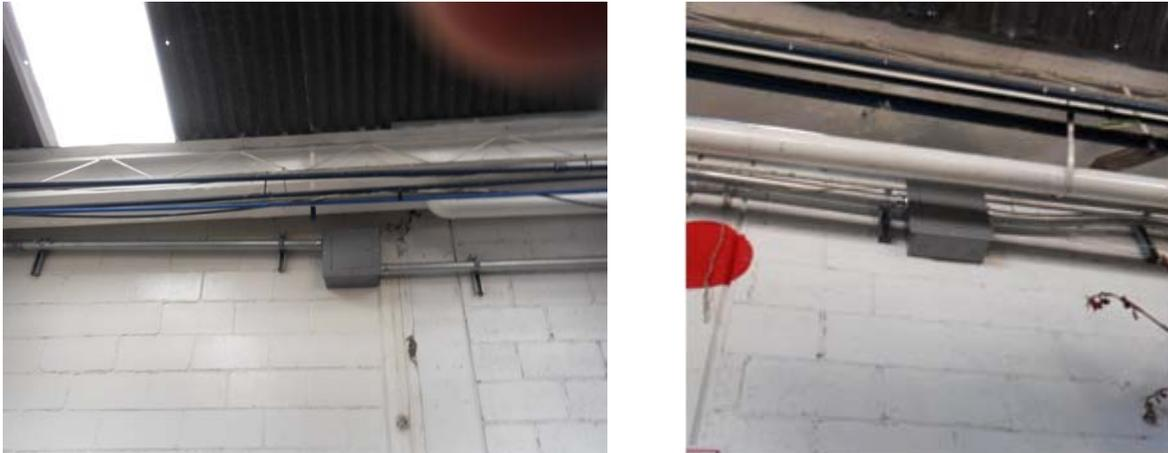
Fig. 3.10 a y b Caja metálica para empalmes de tubería de acuerdo a la tabla 370-16(a) NOM-001-SEDE-2005.
