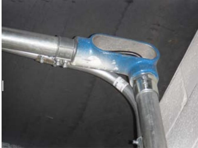
**Fig. 3.23 condulet sin tapa, está ubicado a la entrada del tablero ubicado en almacén.**
