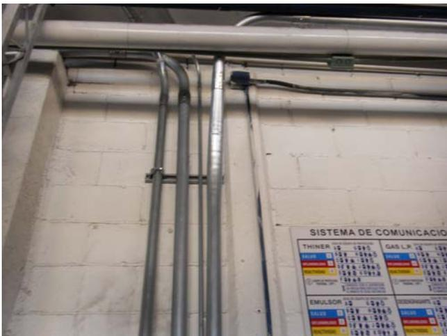
**Fig. 3.15 soporte tipo unicanal con abrazadera en solo una tubería.**
