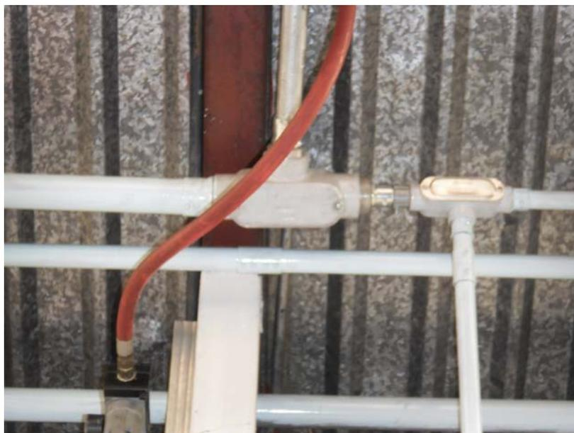
**Fig. 3.9 la Caja de paso de radio reducido (condulet)**
