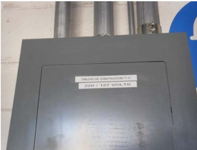
**Fig. 3.14 Etiquetado en el exterior indicando la nomenclatura del mismo, así como su ubicación.**
