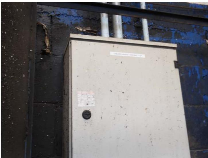
Fig. 3.11 Tablero eléctrico a prueba de goteo
