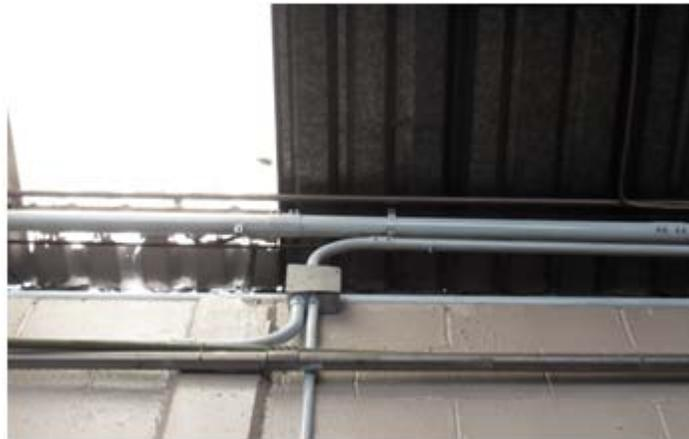
**Fig. 3.8 Caja metálica para empalmes de tubería de acuerdo a la tabla 370-16(a) NOM-001-SEDE-2005**
