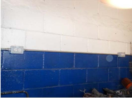
Fig. 3.17 Contactos nuevos etiquetados que indican el tablero y circuito que alimentan a los mismos
