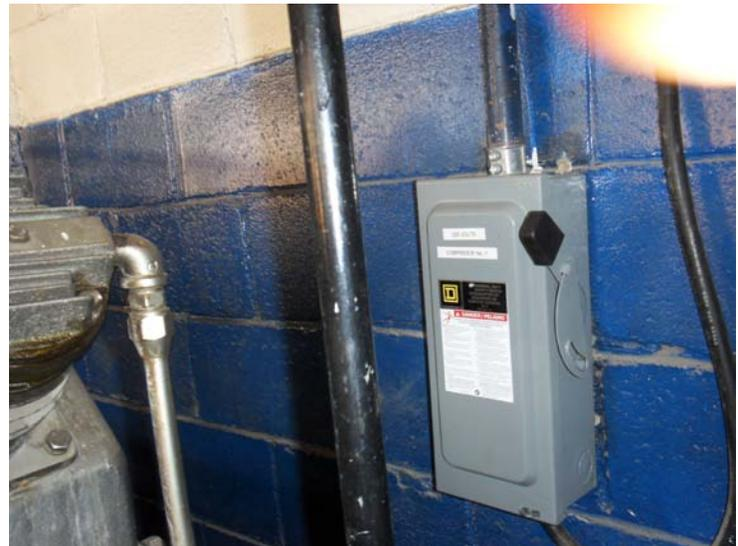
**Fig. 3.16 a y 3.16 b desconectores nuevos en tuberías existentes, se realiza recableado y etiquetado para su correcta ,distinción.**
