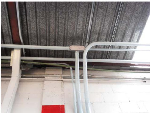
Fig. 3.3 Tuberías de acometida circuitos derivados
