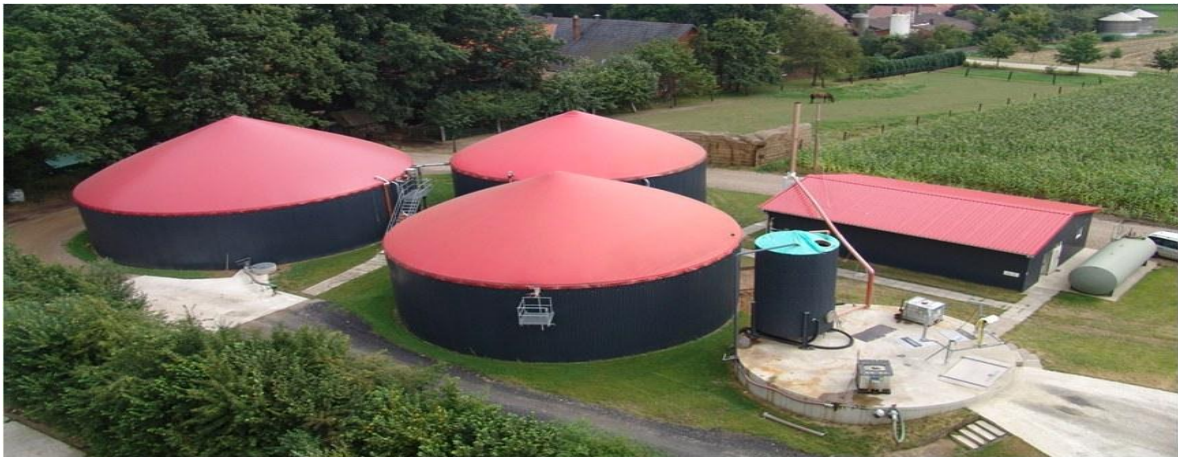
Fig. 2.5 Planta de biogás Tipo Campana Flotante
