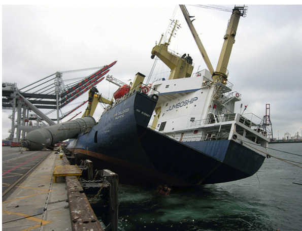
Ilustración 7. Ejemplo de accidente portuario: colapso de carga, con daño al buque y a las instalaciones, fuente: Internet, diversas fuentes. Marzo, 2010.
