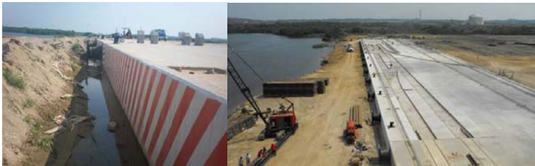
Ilustración 19, Fotos Primera Etapa de Muelle terminado, defensas y bitas, Fuente: API Coatzacoalcos.
