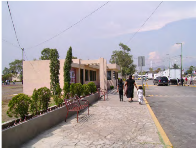
Fachada de Área de Ventas
