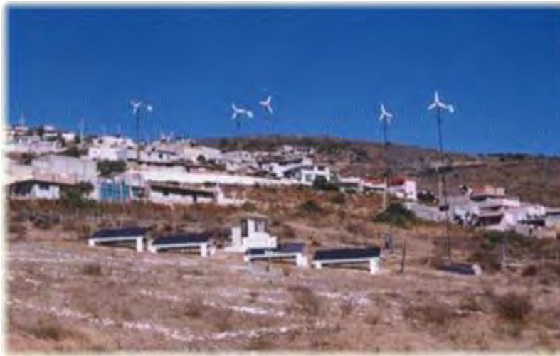
Figura 3.3.2.3: Aspecto típico de un sistema híbrido solar-eólico en un área rural
