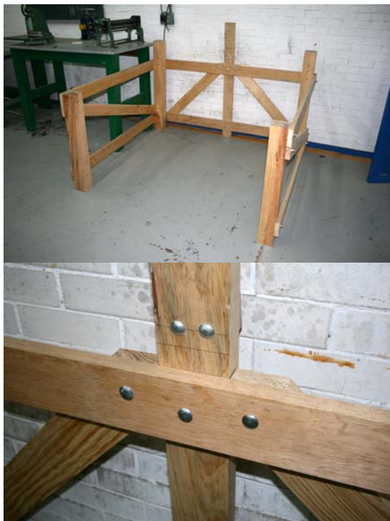
Estructura de madera de pino ensamblada con tornillería comercial galvanizada
