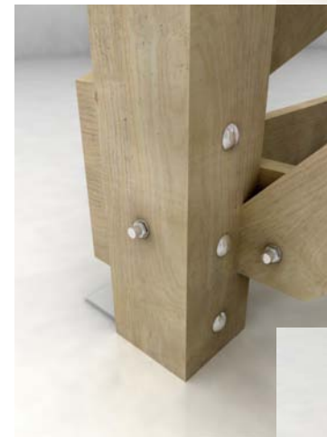
Tornillos “cabeza de coche” y tuercas hexagonales
