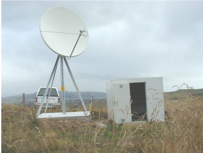
Figura 3-14: Estación remota VSAT.
