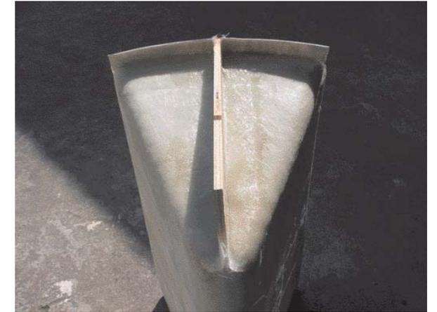
El primer paso fue recubrir el casetón de madera con resina Gel Coat, una vez catalizada se cubrió con fibra de vidrio y cada capa de fibra de vidrio se unió con la ayuda de resina preparada. Éste procedimiento se siguió para la construcción de cada uno de los ocho casetones.
