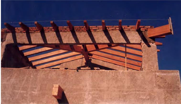
Fig. 4.10 Tolerancia de las Dimensiones de la madera para que no exceda en las colindancias.
