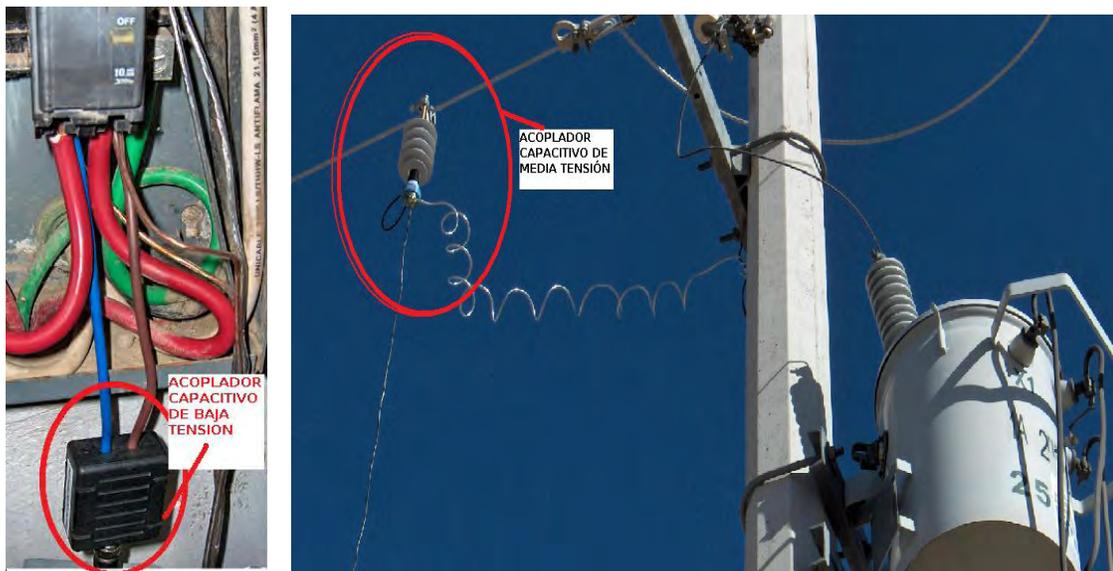
**Fig. 2.2** Acoplador capacitivo de baja y media tensión
