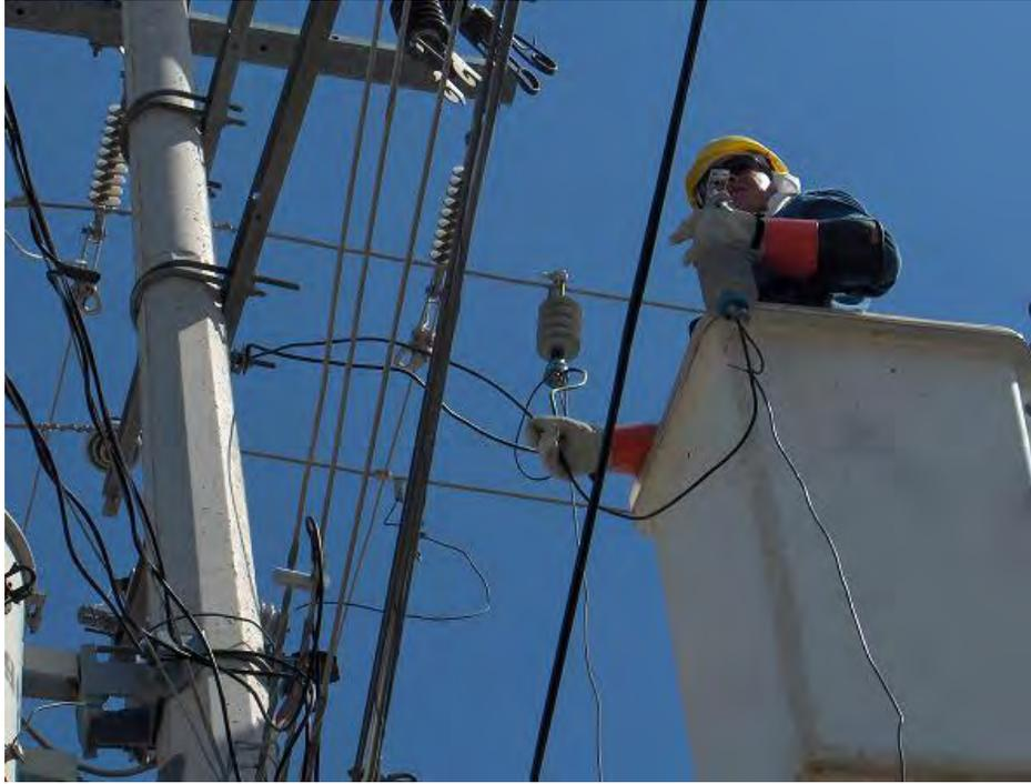
**Fig. A.4** Instalación de acopladores capacitivos en media tensión
